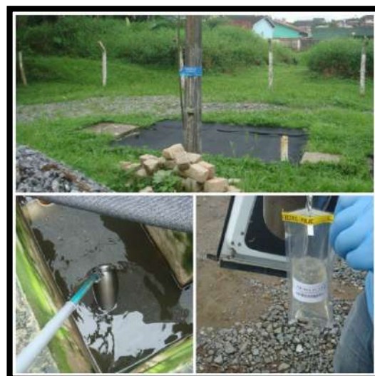
Saída ETE Profipo
