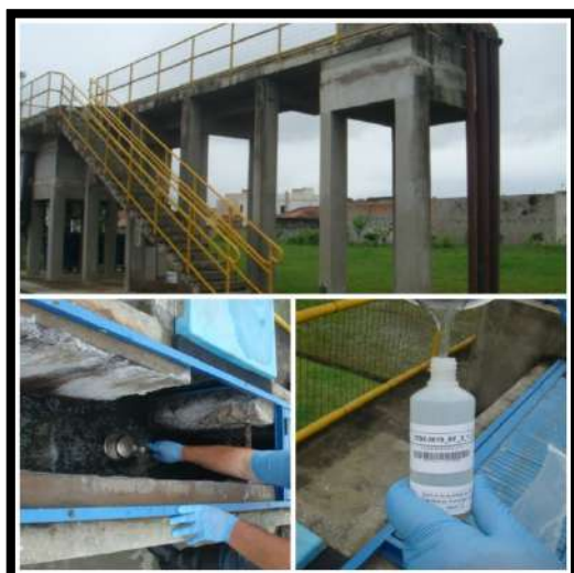
Entrada ETE Espinheiros
