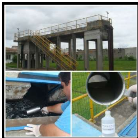
Entrada ETE Espinheiros
