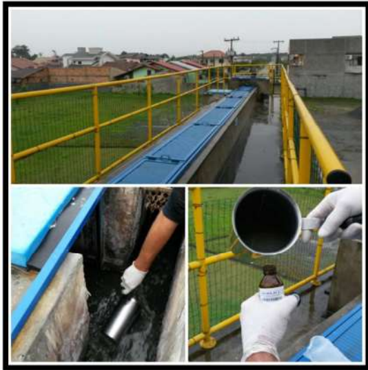
Entrada ETE Espinheiros
