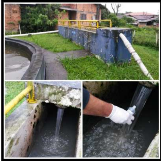
Entrada ETE Profipo
