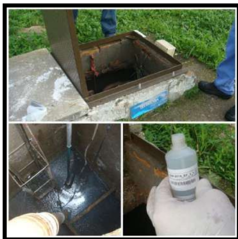
Entrada ETE Profipo
