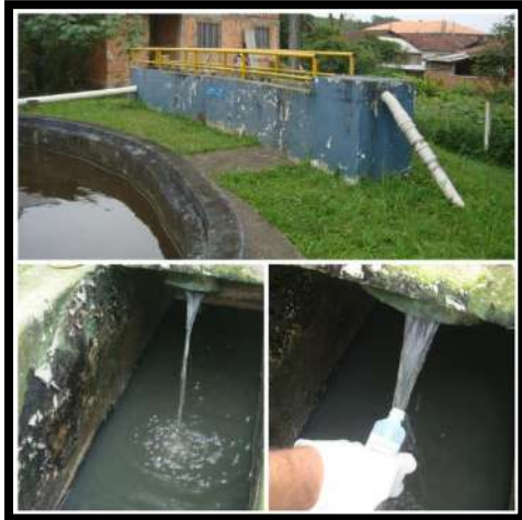
Entrada ETE Profipo
