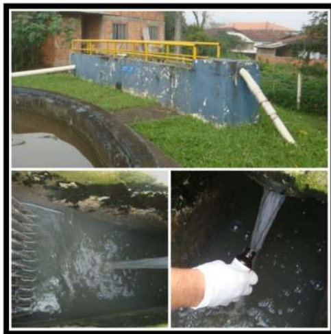
Entrada ETE Profipo
