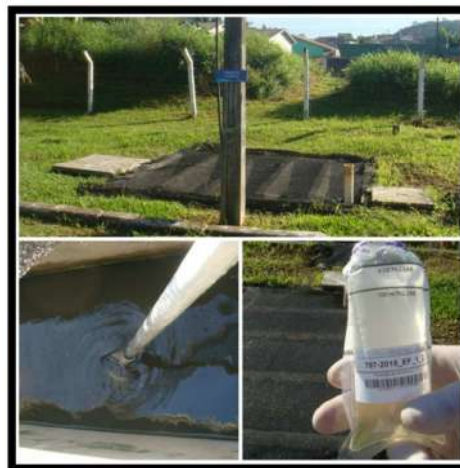
Saída ETE Profipo
