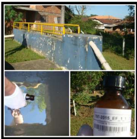
Entrada ETE Profipo
