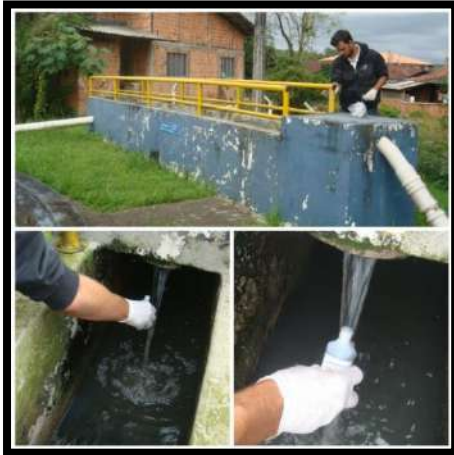
Entrada ETE Profipo
