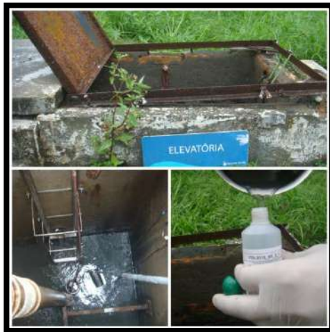
Entrada ETE Profipo
