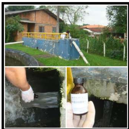
Entrada ETE Profipo
