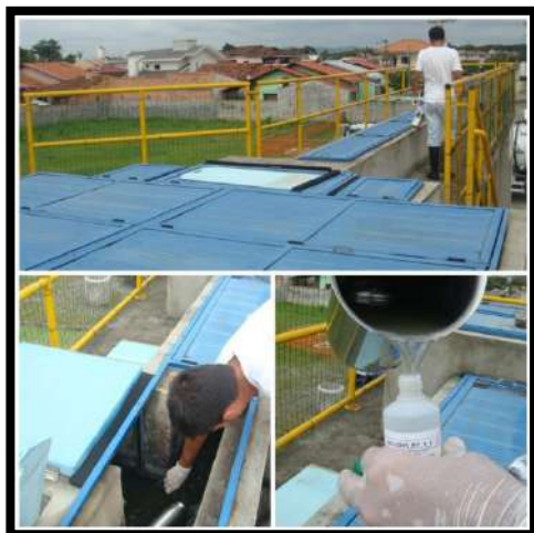
Entrada ETE Espinheiros
