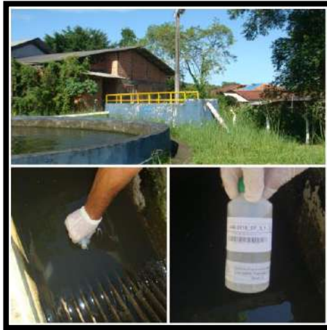
Entrada ETE Profipo
