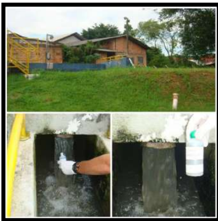
Entrada ETE Profipo
