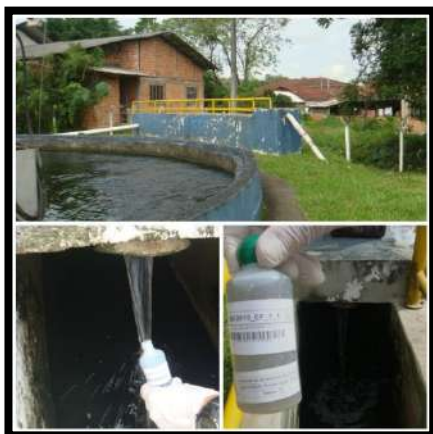
Entrada ETE Profipo
