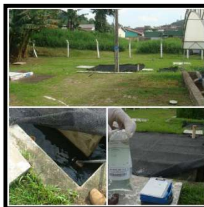
Saída ETE Profipo
