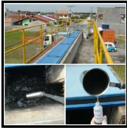
Entrada ETE Espinheiros
