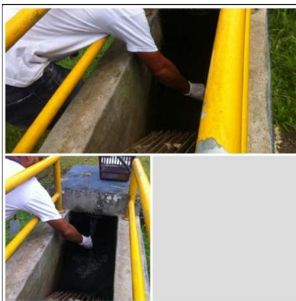
Entrada ETE Profipo
