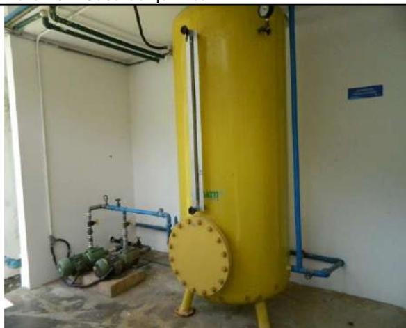
Foto 30 – Cilindro pressurizador
