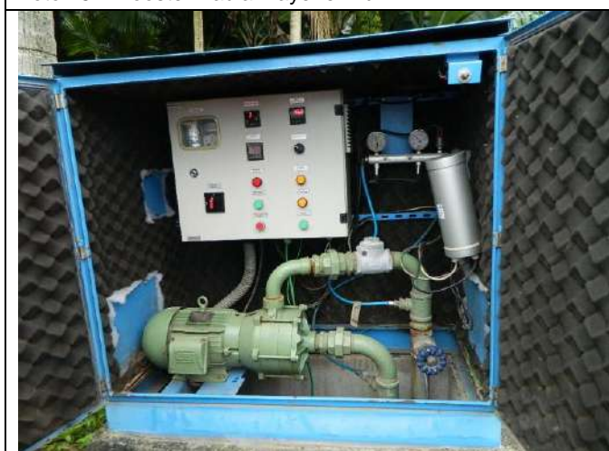
Foto 77 – Booster Paulo Schosslund
