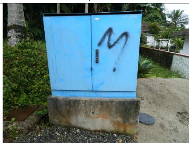
Foto 78 – Booster Paulo Schosslund
