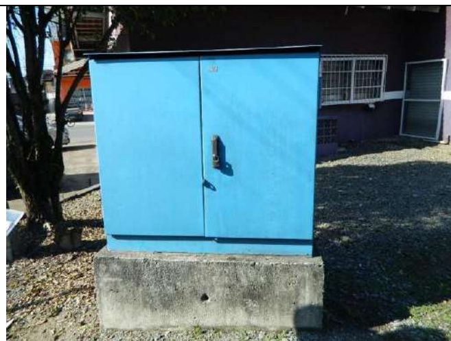
Foto 52 – Booster João de Barro
