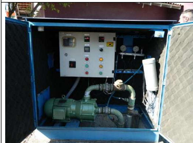
Foto 51 – Booster João de Barro
