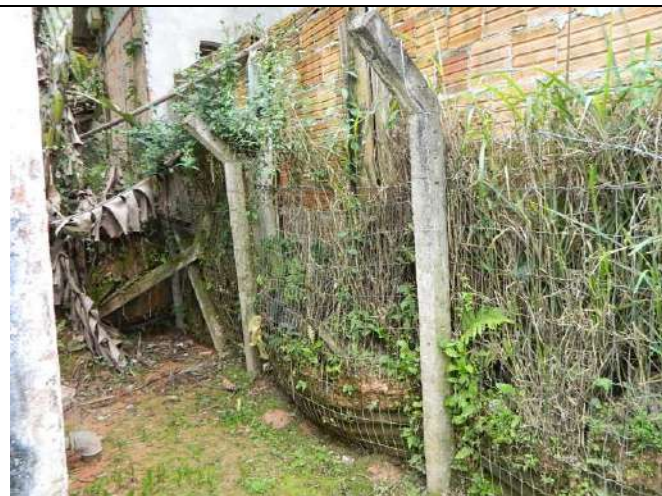
Foto 08 – Booster Alfenas (João Ramalho)
