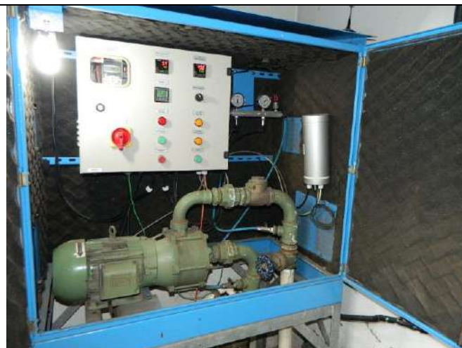
Foto 06 – Booster Alfenas (João Ramalho)
