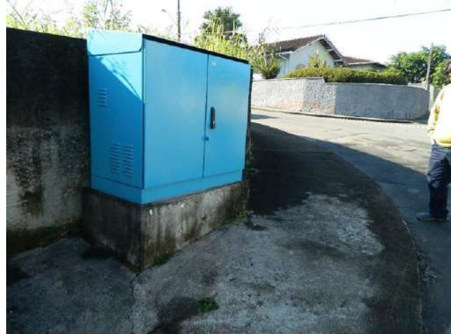
Foto 96 – Booster Três Barras
