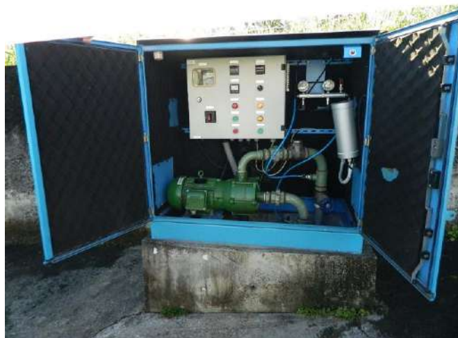
Foto 95 – Booster Três Barras
