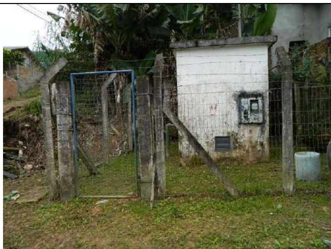
Foto 05 – Booster Alfenas (João Ramalho)
