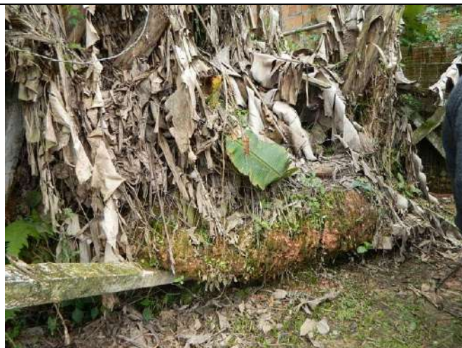
Foto 07 – Booster Alfenas (João Ramalho)
