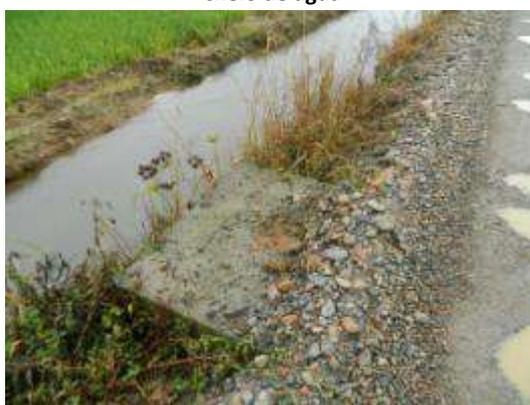
Foto 90 – Tampa do abrigo da descarga da adutora de 700 mm, travada e coberta de detritos.
