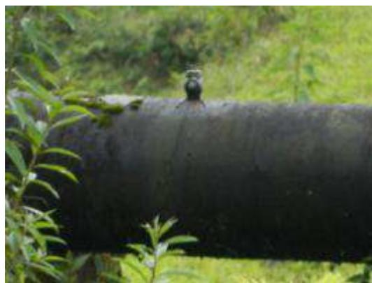
Foto 144 – Ponto de pitometria da adutora de 450 mm
