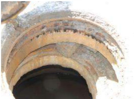
Foto 130 – Estrutura de concreto do abrigo da adutora de 700 mm em cima de outra estrutura de concreto
