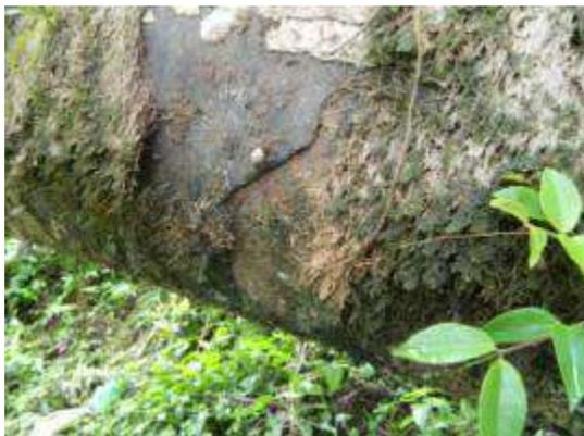
Foto 167 – Falha no revestimento da adutora
