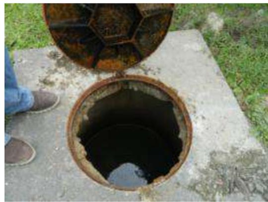
Foto 538 – Abrigo da descarga da adutora de 700 mm –
