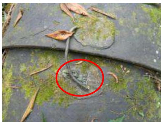
Foto 10 – Cabo de proteção catódica danificado na adutora de 900 mm
