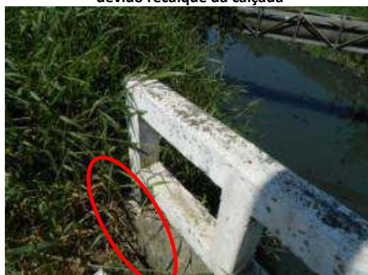
Foto 80 – Rua Suburbana – Descolamento do guarda-corpo da calçada devido recalque
