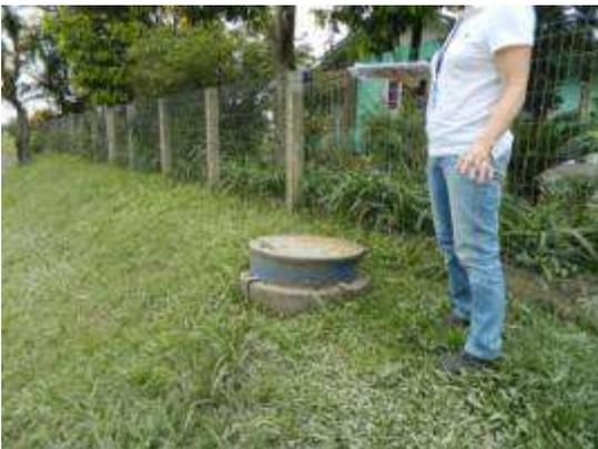
Foto 67 – Abrigo da descarga da adutora de 350 mm
