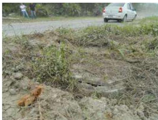
Foto 98 – Tampa do abrigo do registro a adutora de 350 mm levemente deslocada
