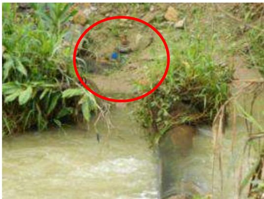
Foto 95 – Descarga da adutora de 350 mm sem proteção e assoreada.
