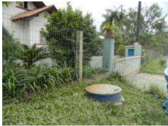
Foto 68 – Abrigo da descarga da adutora de 350 mm
