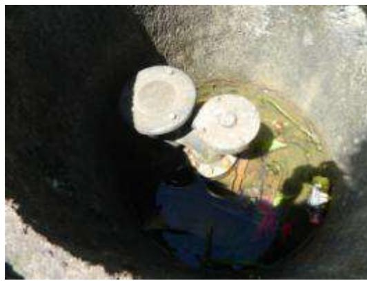
Foto 54 – Abrigo da ventosa da adutora de 350 mm com água
