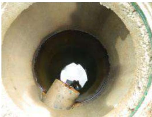
Foto 108 – Abrigo da descarga cheio de água
