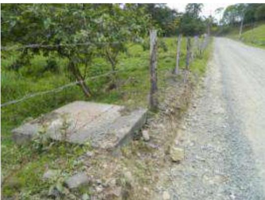
Foto 537 – Abrigo da descarga da adutora de 700 mm
