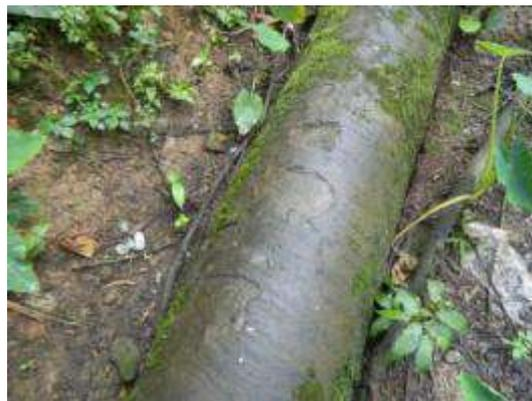
Foto 146 – Falha no revestimento da adutora
