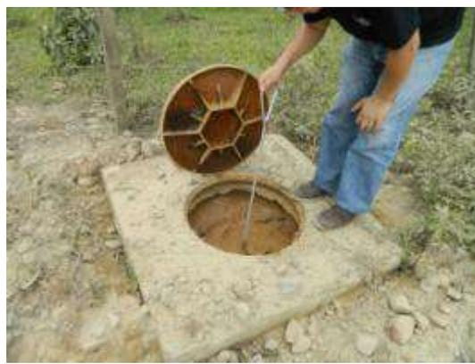
Foto 78 – Abrigo da descarga da adutora de 700 mm, assoreada
