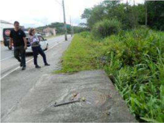
Foto 5618 – Tampa do abrigo da descarga da adutora de 700 mm
