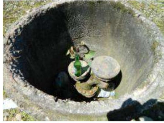
Foto 80 – Abrigo da descarga da adutora de 350 mm, sem proteção
