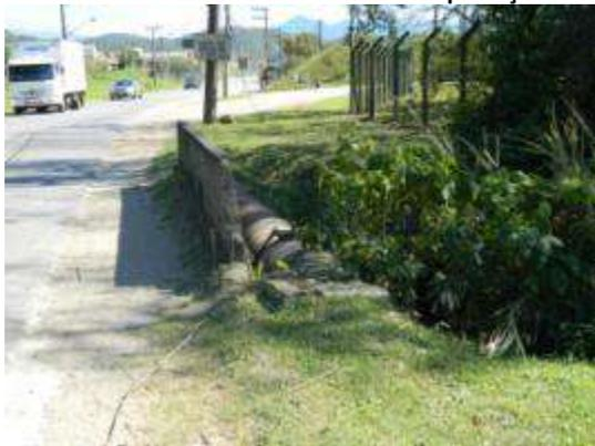
Foto 41 – Adutora de 700 mm sem proteção adequada
