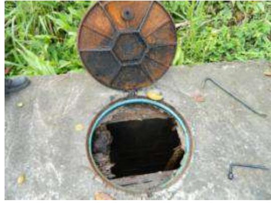
Foto 119 – Tampa do abrigo da descarga da adutora de 700 mm com resto da caixaria
