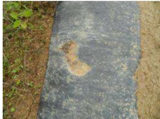
Foto 156 – Falha no revestimento na adutora
