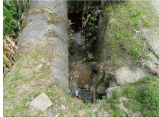
Foto 46 – Margem erodida junto a adutora
