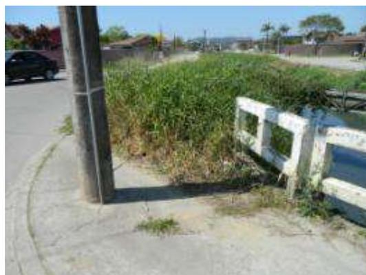
Foto 78 – Rua Suburbana – Risco de queda do poste devido recalque da calçada
