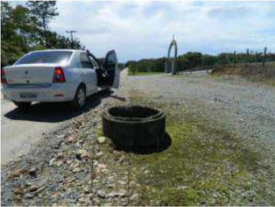
Foto 79 – Abrigo da descarga da adutora de 350 mm
