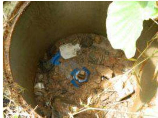
Foto 117 – Abrigo da descarga da adutora de 700 mm assoreada
