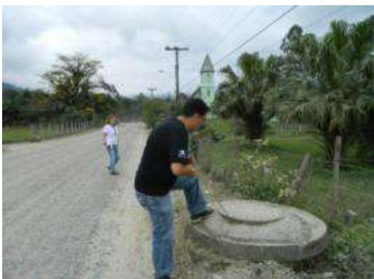
Foto 741 – Abrigo da descarga da adutora de 700 mm
