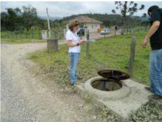
Foto 75 – Abrigo da descarga da adutora de 700 mm
