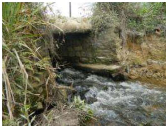
Foto 86 – Erosão junto à adutora de 350 mm
