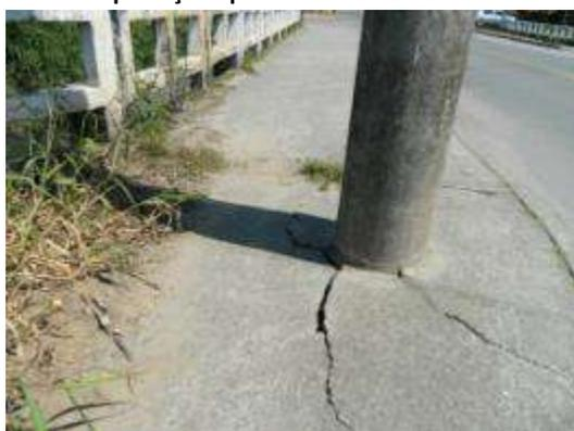
Foto 79 – Rua Suburbana – Risco de queda do poste devido recalque da calçada
