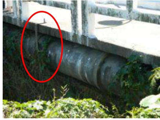
Foto 58 – Fixação da adutora com cinta de ancoragem
