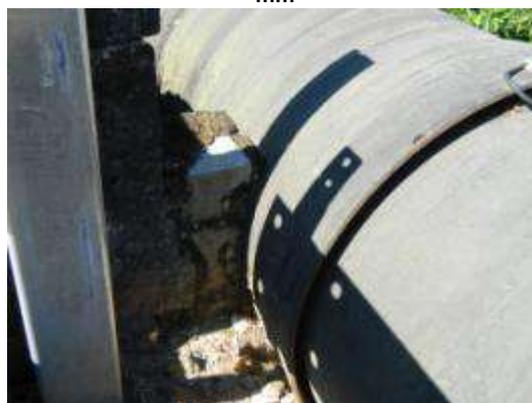
Foto 32 – Adutora de 900 mm apoiado na base de concreto sem proteção
