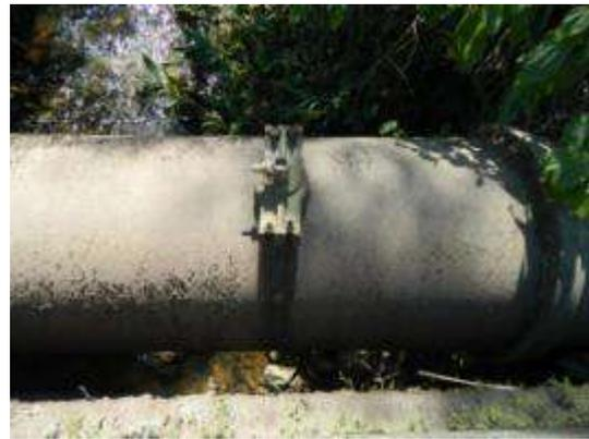
Foto 42 – Ponto de pitometria, na adutora de 700mm
