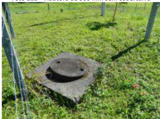
Foto 213 – Tampa do abrigo mal encaixada
