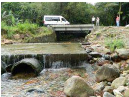
Foto 343 – Rio Cateto. Vista da adutora de 350 mm em primeiro plano, e adutora 700 mm, ao fundo, junto à ponte
