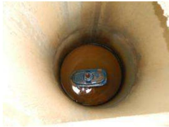
Foto 76 – Abrigo da descarga da adutora de 700 mm
