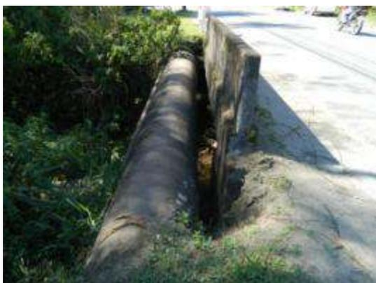
Foto 416 – Margem erodida junto a adutora
