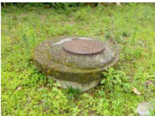
Foto 255 – Abrigo da descarga da adutora de 700 mm
