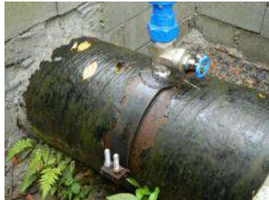
Foto 12 – Oxidação por falta de pintura junto à
