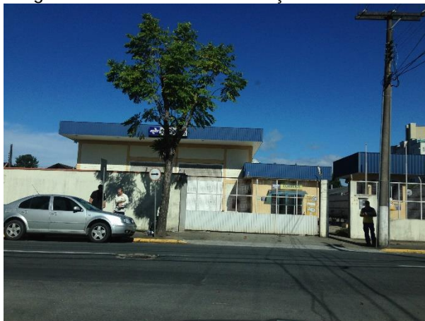
Figura 44: Unidade de distribuição dos Correios
