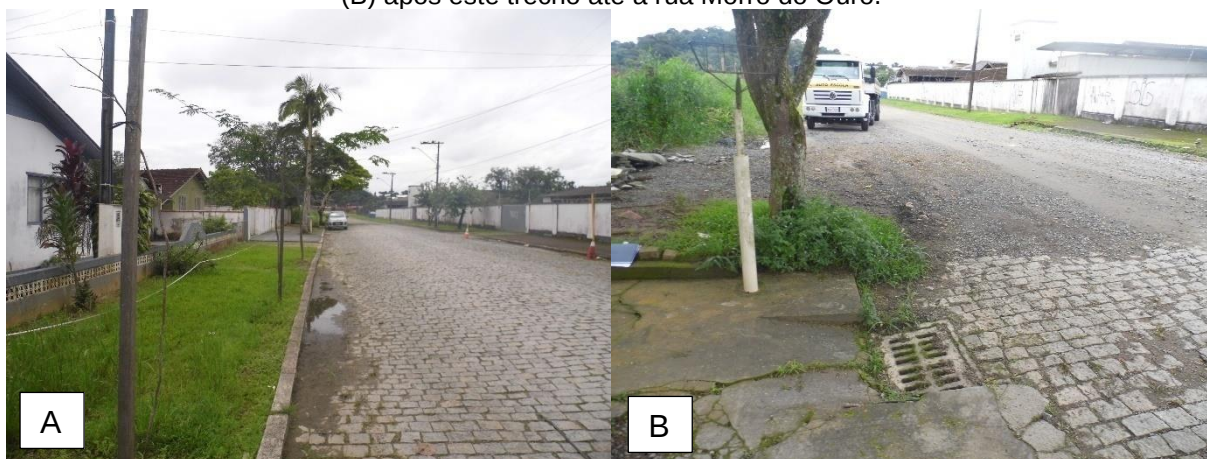
Figura 53: Rua Afonso Pena com pavimento de paralelepípedo (A) nos primeiros 55m e sem pavimento (B) após este trecho até a rua Morro do Ouro.
