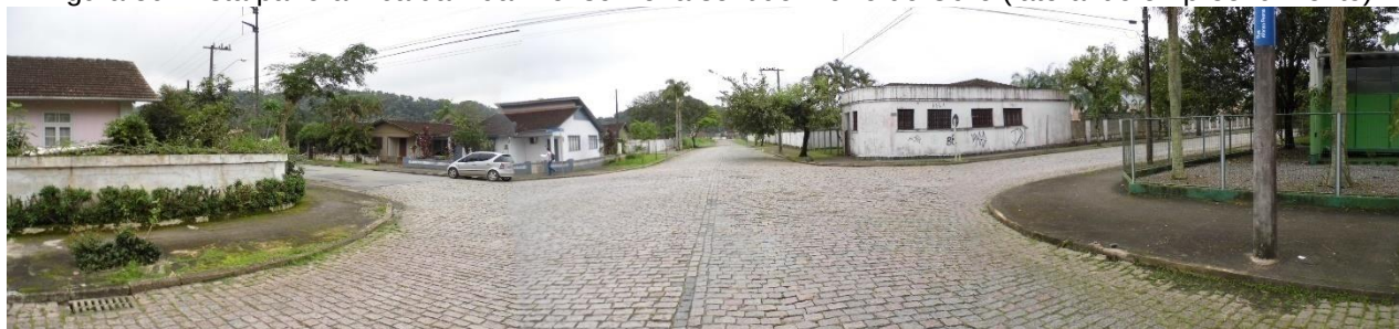
Figura 59: Vista panorâmica da Rua Afonso Pena sentido Morro do Ouro (lateral do empreendimento)
