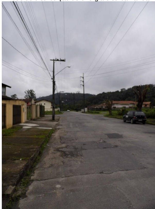
Figura 51: Rede de distribuição de energia elétrica na rua Porto Belo.
