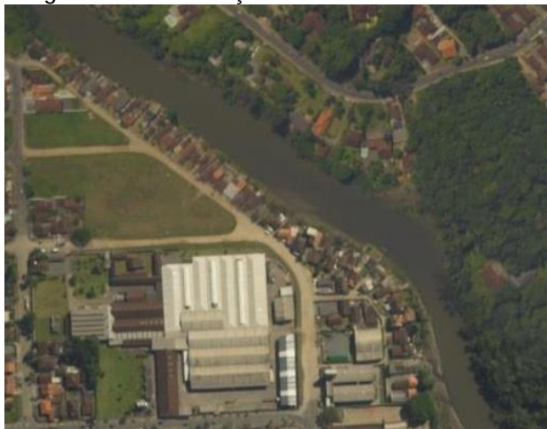
Figura 29 – Construções residenciais em APP
