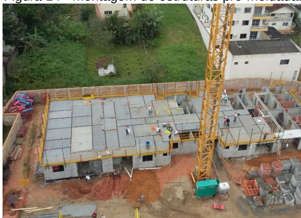
Figura 14 - Montagem de estruturas pré-moldadas
