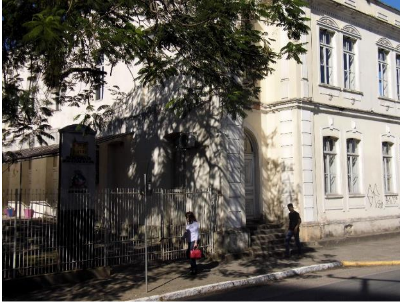
Figura 9: Imóvel tombando na AID
