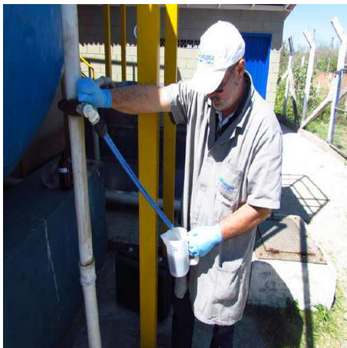
Figura 3: Ponto 2 - Entrada ETE Morro do Amaral
