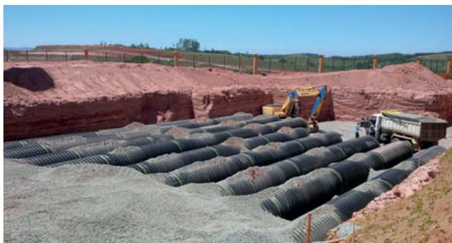
**Projeto:** SISTEMA DE ÁGUAS PLUVIAIS INSTALADO SOB O PÁTIO DE MANOBRAS DE UM GRANDE EMPREENDIMENTO DE GALPÕES INDUSTRIAIS
