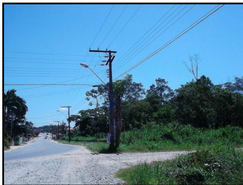
Figura 13: Equipamentos Urbanos localizados na área de estudo (Abastecimento de energia elétrica). Fonte: Arquivo Pessoal, 2014.
