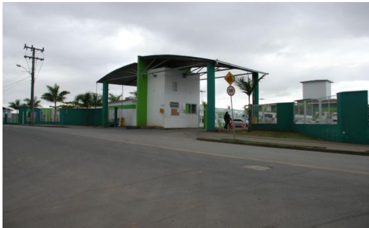
Figura 5: Ponto de medição 01, em frente ao IFSC. Fonte: autor.
