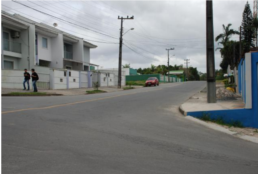
Figura 6: Ponto de medição 02, Rua Pavão esquina com a Rua Adolfo Ritzmann. Fonte: autor
