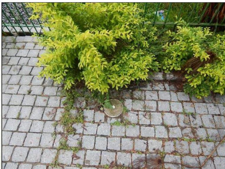
**Figura 42.** Detalhe da caixa de inspeção de esgoto sanitário da antiga unidade residencial do imóvel, onde se pretende construir o Edifício.
