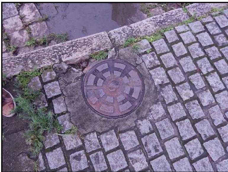
**Figura 41.** Detalhe da caixa de inspeção de esgoto sanitário da antiga unidade residencial do imóvel, onde se pretende construir o Edifício Chateau Drappier.
