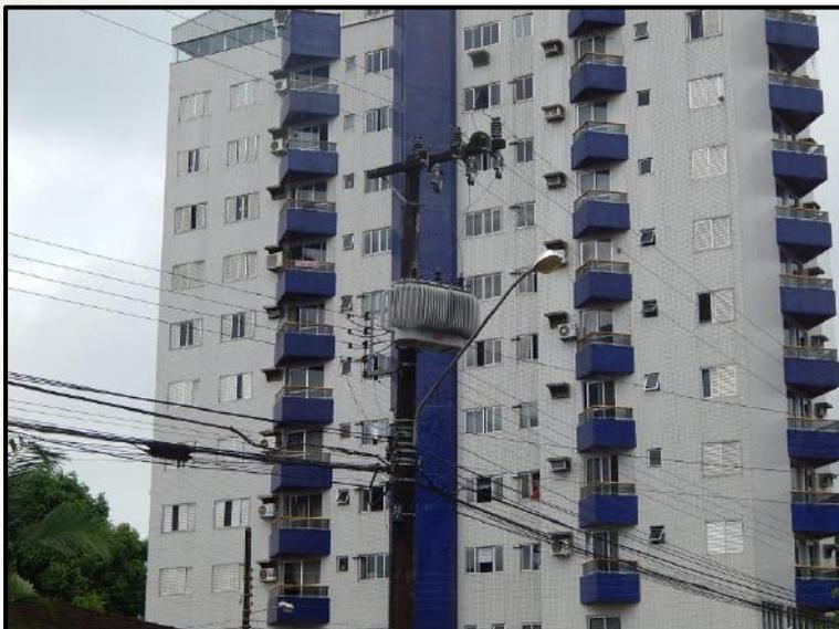
**Figura 42.** Transformador de tensão de energia, que alimenta a rede da vizinhança do empreendimento.
