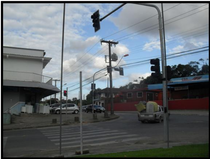
Figura 16: Ponto 01 – Rua Jarivatuba (frente ao posto de combustível)
