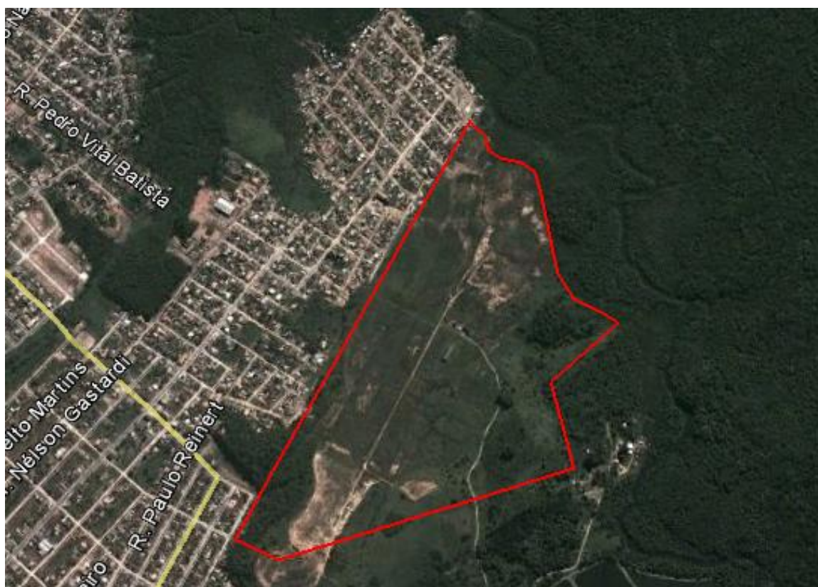
Figura 01: Lote a ser Implantado o Empreendimento..
