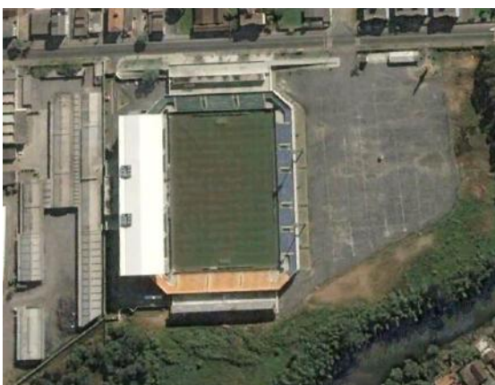
Figura 03 – Arena Joinville antes da ampliação.
