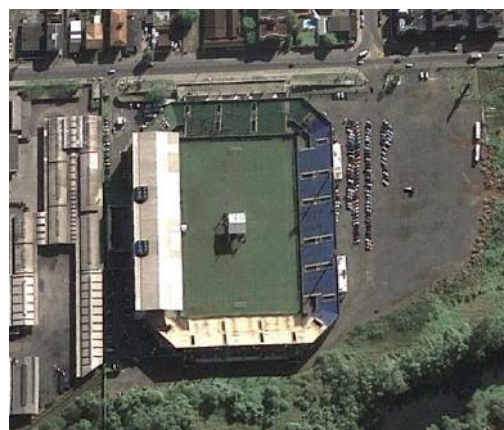
Figura 04 – Arena Joinville após ampliação.
