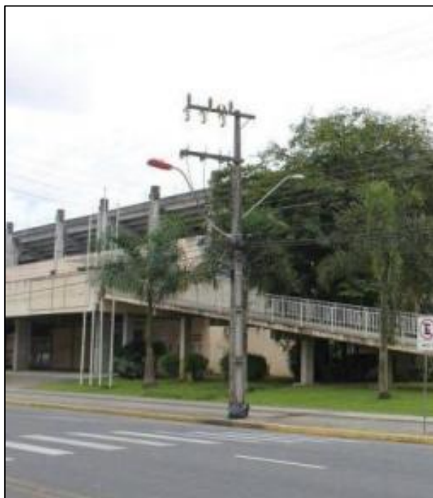
Figura 25: Entrada de energia para o empreendimento.
