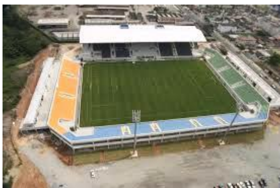
Figura 01 – Arena Joinville antes da ampliação.
