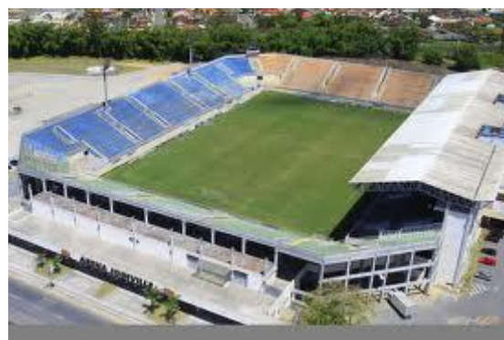
Figura 02 – Arena Joinville após ampliação.
