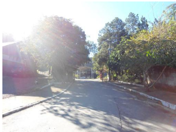
Figura 16: Local em logradouro em frente ao imóvel objeto, observa-se a servidão que dá acesso à divisão de pavimentação da Prefeitura Municipal de Joinville.
