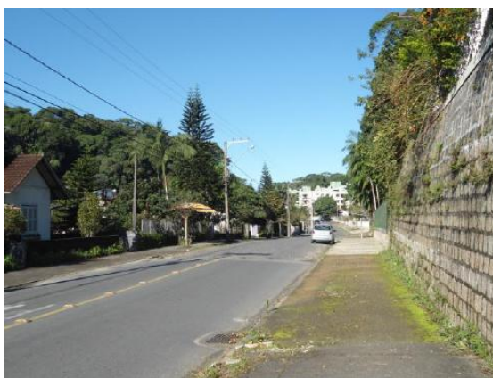
Figura 56: Visualização da caixa de drenagem
