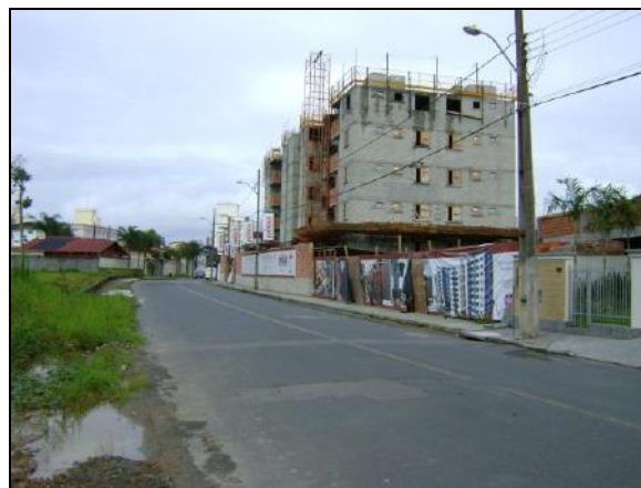
Figura 02: Posteamto e iluminação pública da rua João Vogelsanger, durante o dia.
