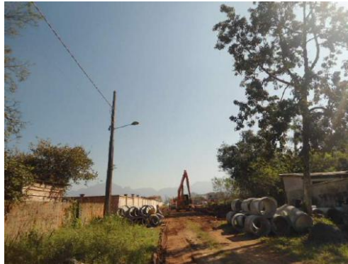
Figura 71: Obras de drenagem no Prolongamento da Rua Hildo Novaes, em frente ao imóvel
