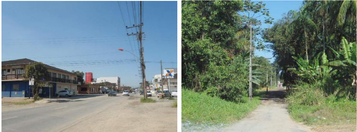
Figuras 68 e 69: Posteamto da Rua XV de Novembro e da rua de acesso ao imóvel
