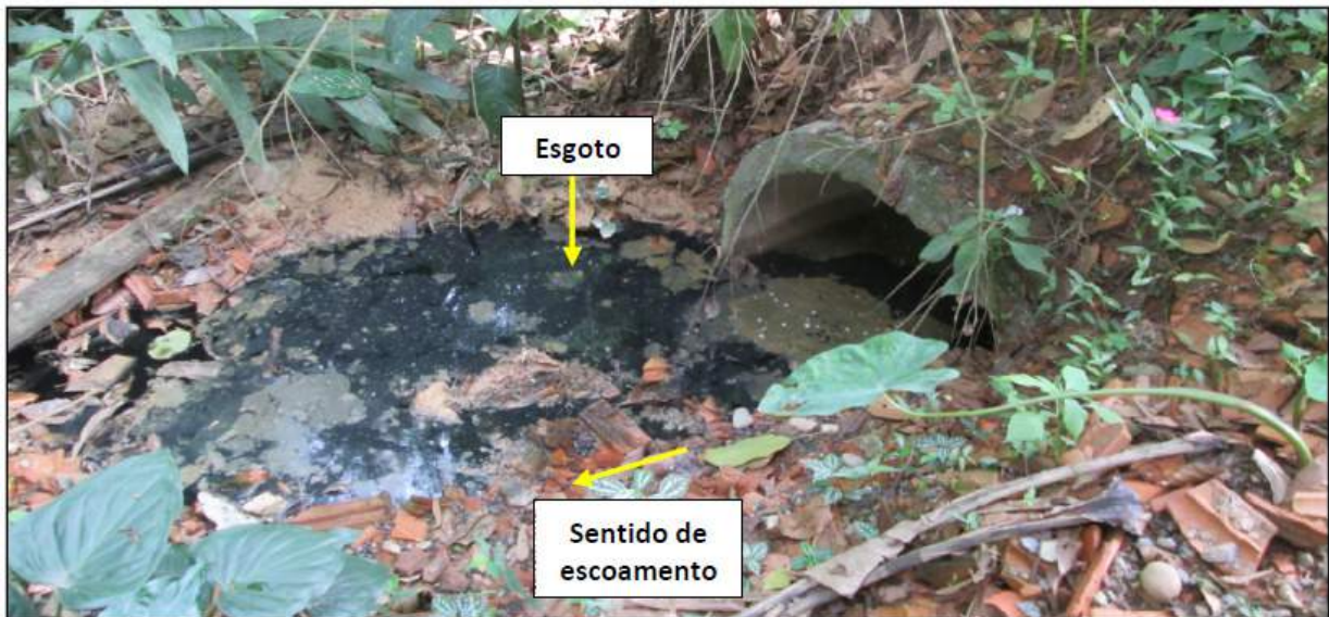
Figura 32: Esgoto existente na lateral leste do imóvel.
