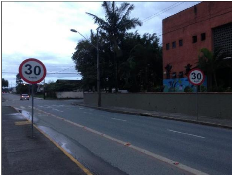
Imagem 56: Escola Municipal Profª Karin Barkemeyer. Visão da placa redutora de velocidade na Rua São Firmino.
