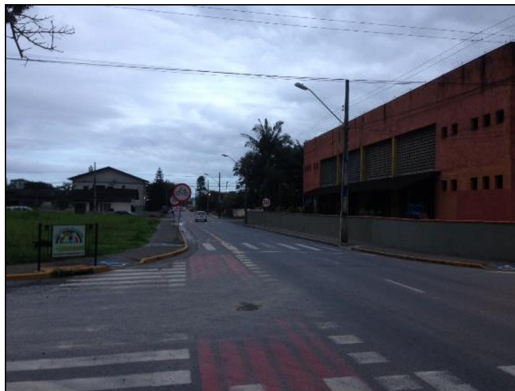
Imagem 55: Escola Municipal Profª Karin Barkemeyer. Visão R. São Firmino, Ciclovia e Cruzamento de Veículos.
