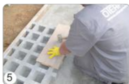
5 Nivelamento e Compactação
