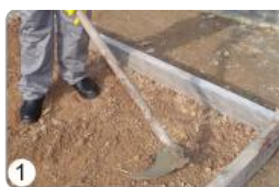
1 Preparação do terreno
