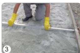
3 Colocação, distribuição e nivelamento da areia
