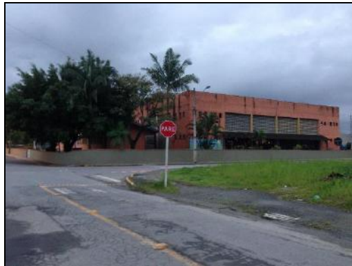
Imagem 54: Escola Municipal Profª Karin Barkemeyer. Visão da Rua Márcio Luckow esquina com Rua São Firmino.
