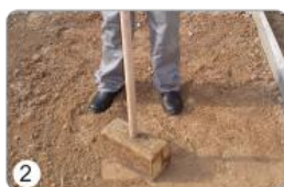
2 Compactação do terreno
