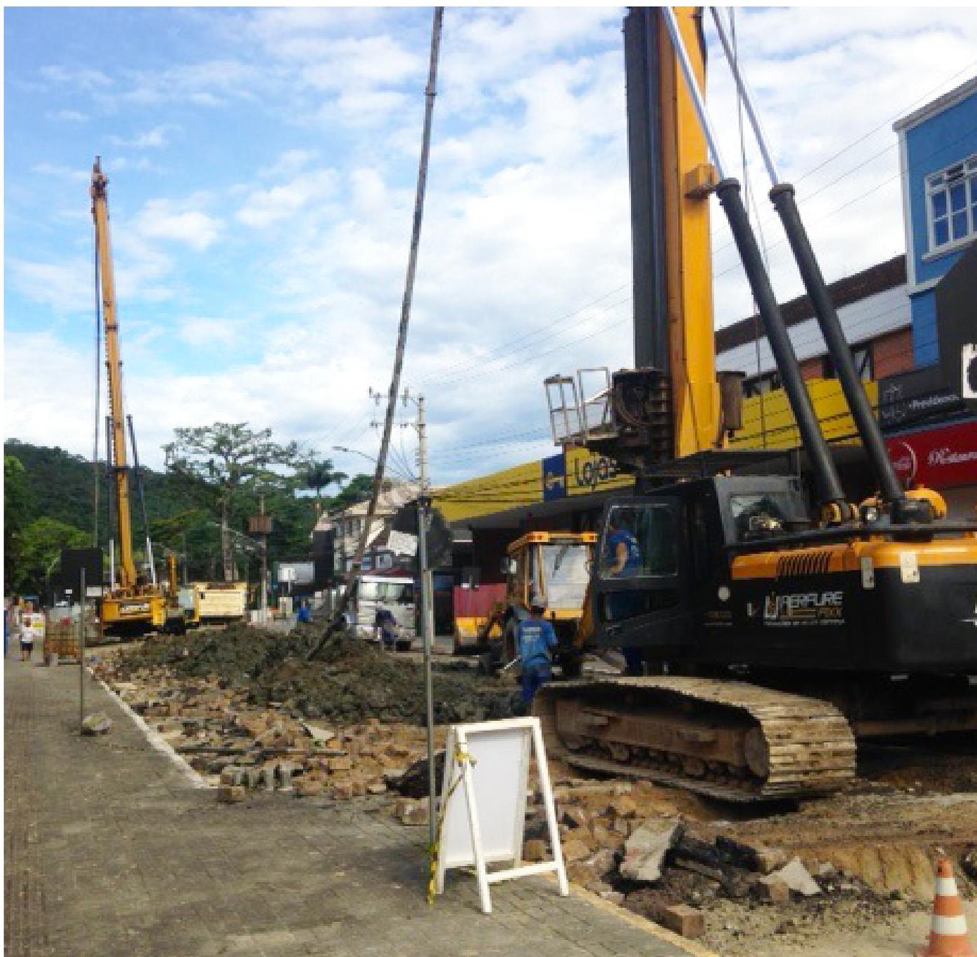
**OBRAS RIO MATHIAS** - Os trabalhos do Projeto de Ampliação da Vazão do Rio Mathias, iniciados na área central no final do ano passado, ocorrem sem contratemplos. As férias escolares e a ausência de obstáculos no mapeamento e estaqueamento do conduto forçado na rua Jerônimo Coelho, colaboram para o bom andamento. A previsão é que até o final deste ano as galerias subterrâneas estejam implantadas na região central.
