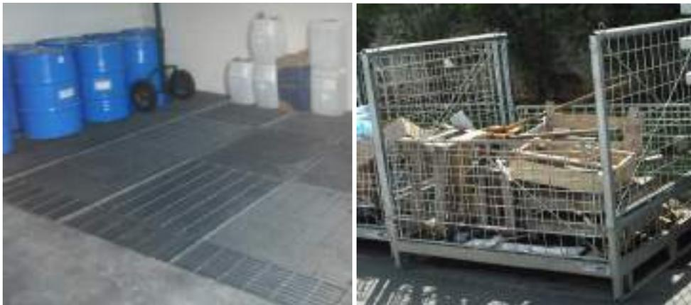
*Figura 120: Camara fria para resíduos orgânicos com canaleta de contenção e Segregação de estopas contaminadas*
