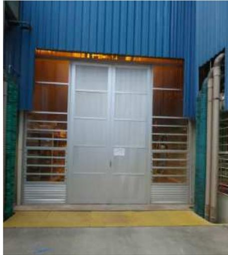
*Figura 26: Conserto da porta do setor de Granulação. Permanece fechada, exceto para a passagem de empilhadeiras (antes e depois)*
