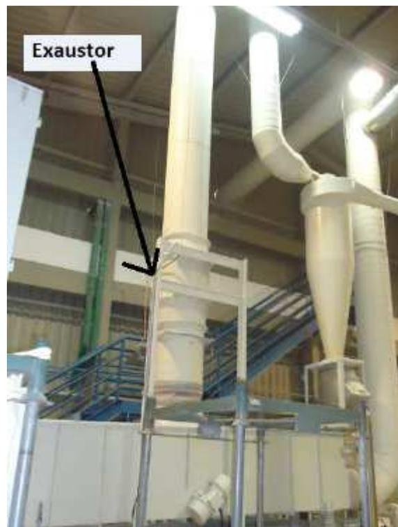
*Figura 29: Instalado atenuador acústico no duto da granuladeira citada acima e na granuladeira Battenfeld.*
