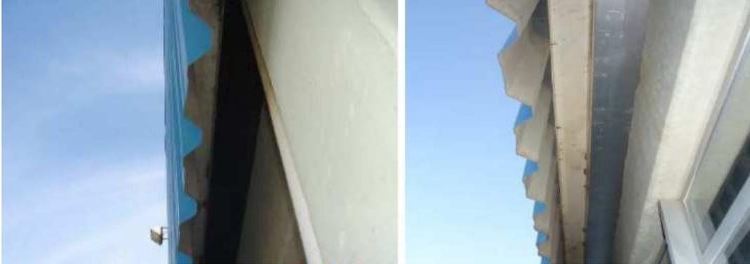
*Figura 15: Vedação das janelas basculantes com rebite*
