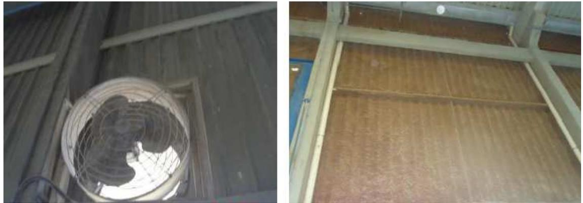
*Figura 18: Rotacionamento da coifa de saída do duto do setor de Granulação, localizado no telhado, em 135° (direção das árvores, Rua Afonso Schneider), para que as ondas sonoras emitidas não encontrem paredes ou superfícies, ocorrendo reflexões.*
