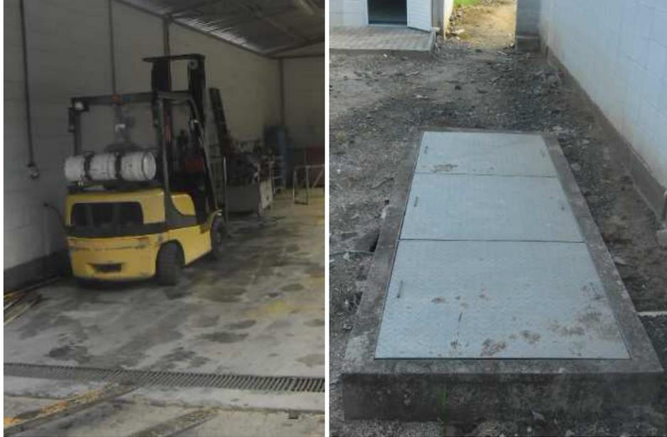
*Figura 119: Bacia de contenção para armazenamento de óleo e segregação de resíduos de madeira*
