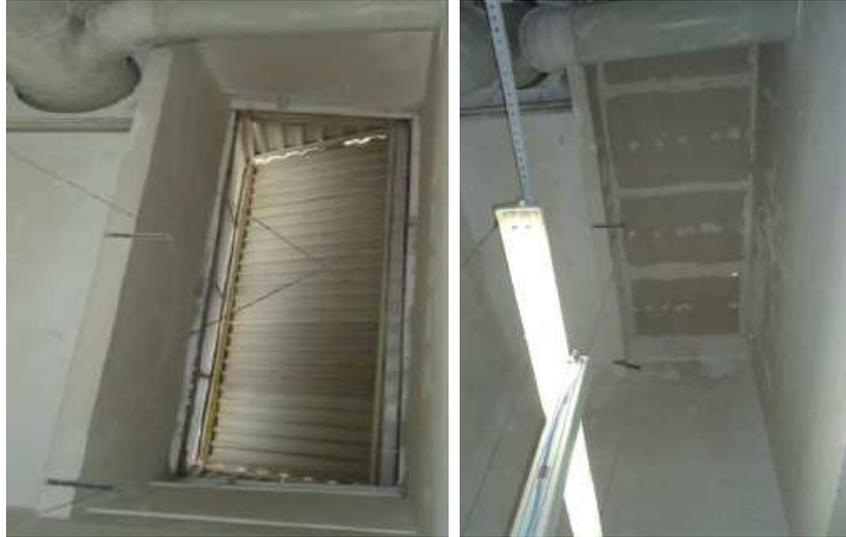
*Figura 20: Colocação de lã de vidro acima da placa de gesso acartonada, no setor de granulação*
