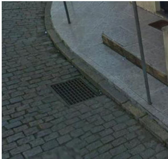
Figura 52: Visualização da caixa de drenagem na Rua Carlos Lang
