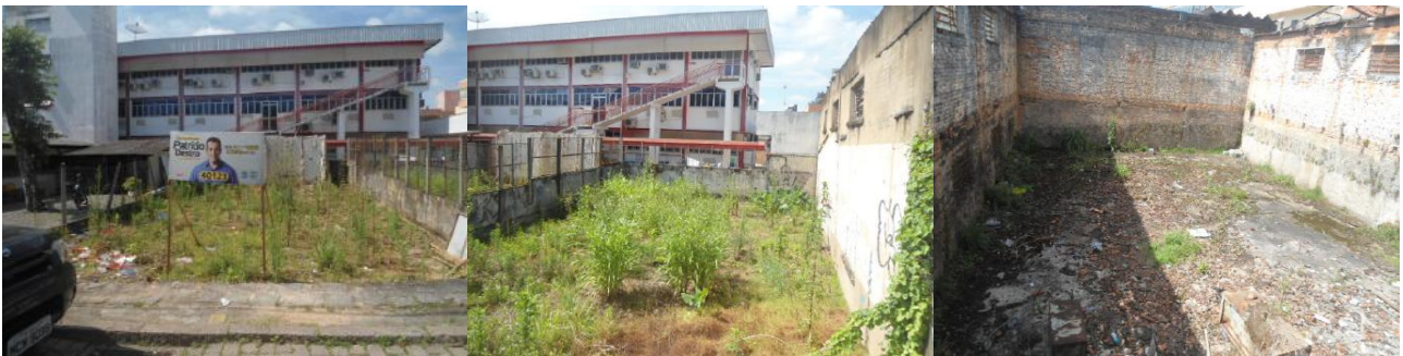
Figura 05: Aspectos internos do perímetro do imóvel
