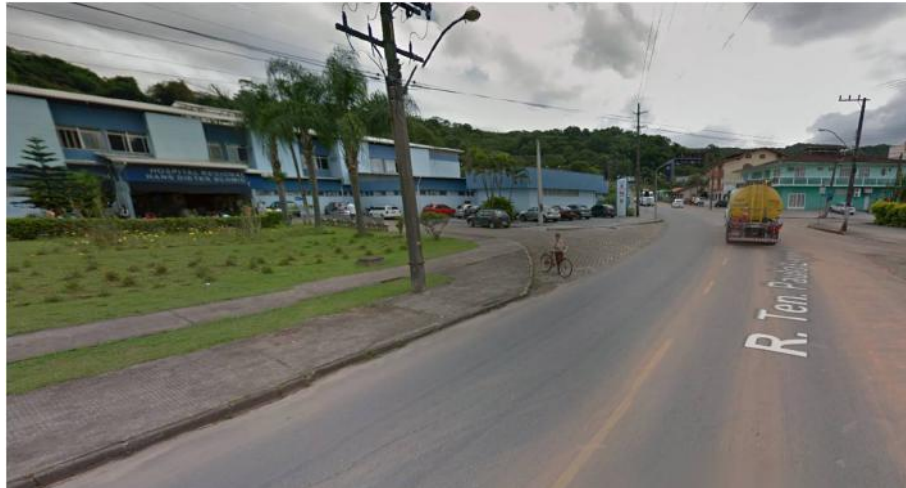
Figura 27- Rua Pavimentada em Frente ao Hospital Regional
