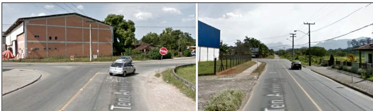
Fotografia 5 Rua Tenente Antônio João - Sinalização Vertical.
