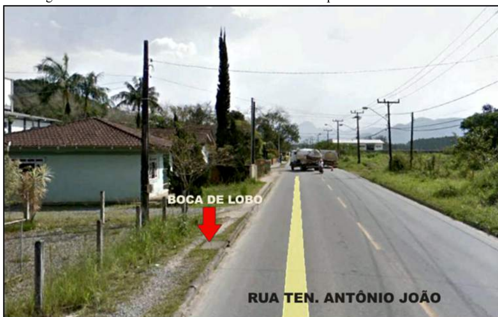
Fotografia 03 - Rua Tenente Antônio João (Com Bueiros e/ou Bocas-de-Lobo). Fonte: Google Street View. Acessado em 12/10/2016. Editado por André L. Becker em 12/10/2016.
