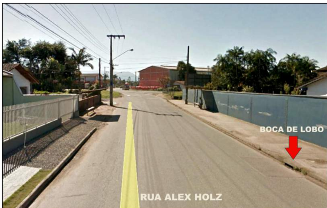
Fotografia 04 - Rua Alex Holz (Com Bueiros e/ou Bocas-de-Lobo). Fonte: Google Street View. Acessado em 12/10/2016. Editado por André L. Becker em 12/10/2016.
