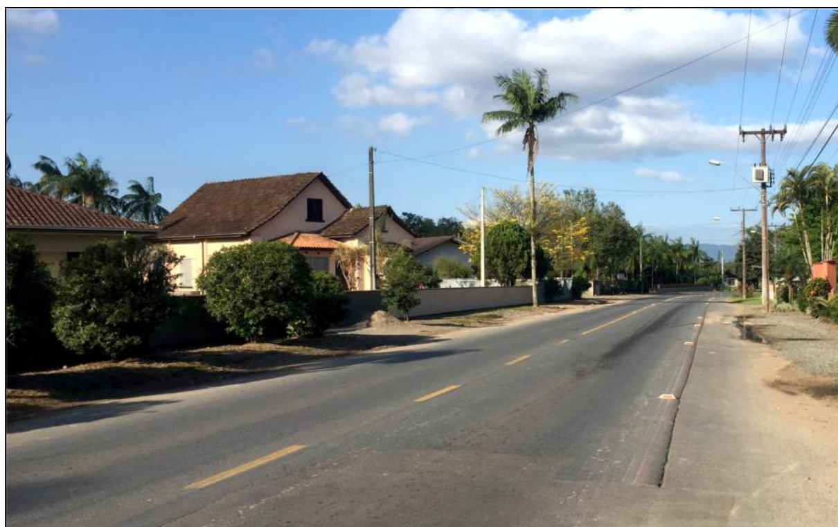
Fotografia 6 Estrada da Ilha - Sinalização Horizontal.
