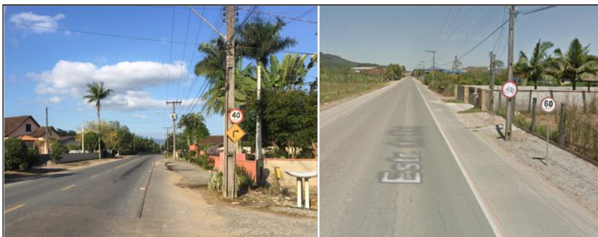
Fotografia 25 - Estrada da Ilha - Sinalização Vertical.
