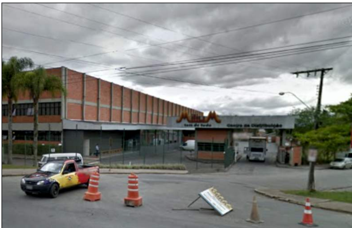
Fotografia 23 - Marco 06 - Centro de Distribuição Millium. Fonte: Google Street View. Acessado em 12/10/2016.
