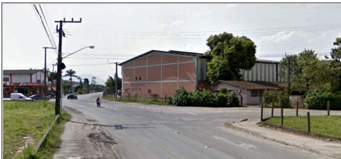
Fotografia 7 Rua Alex Holz - Sinalização Horizontal.
