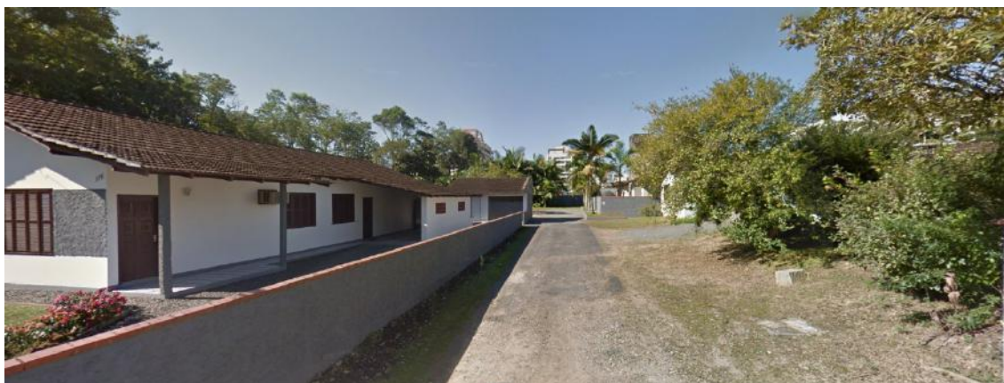
Figura 10 – Acesso à Serv. sem nome 02 – Fonte: Google Street View (Jun 2015)
