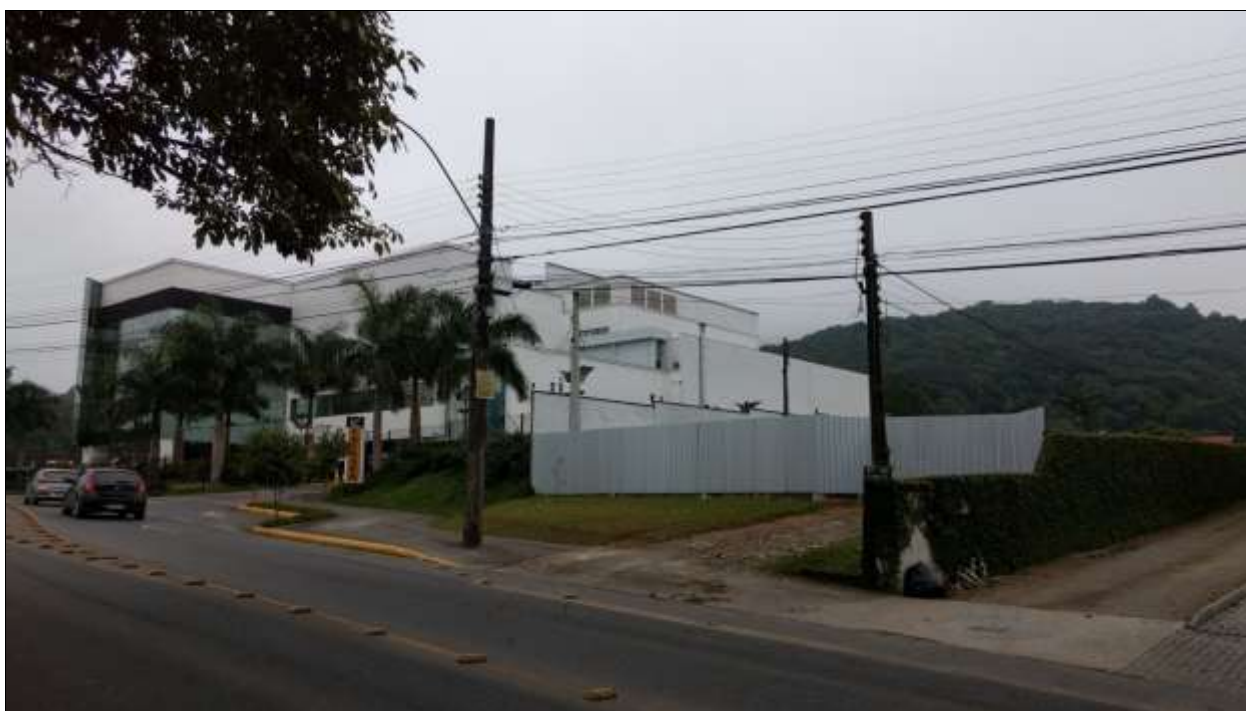
Figura 8: Local de Instalação.
