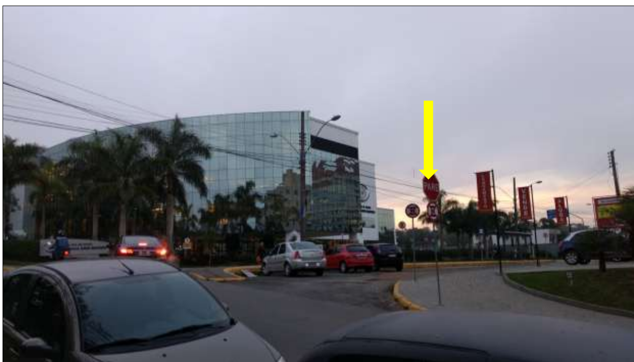
Figura 52: Vista para o local onde será construído o edifício.
