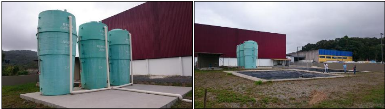
Figura 123. Vista geral da estação de tratamento de efluentes por reator UASB da empresa.
