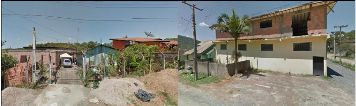
Figura 93. Na região existem muitas residências de madeira e casas de alvenaria como os chamados 'puxados'.
