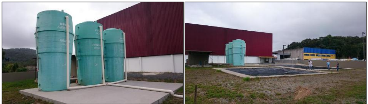
Figura 82. Vista geral da estação de tratamento de efluentes por reator UASB da empresa.
