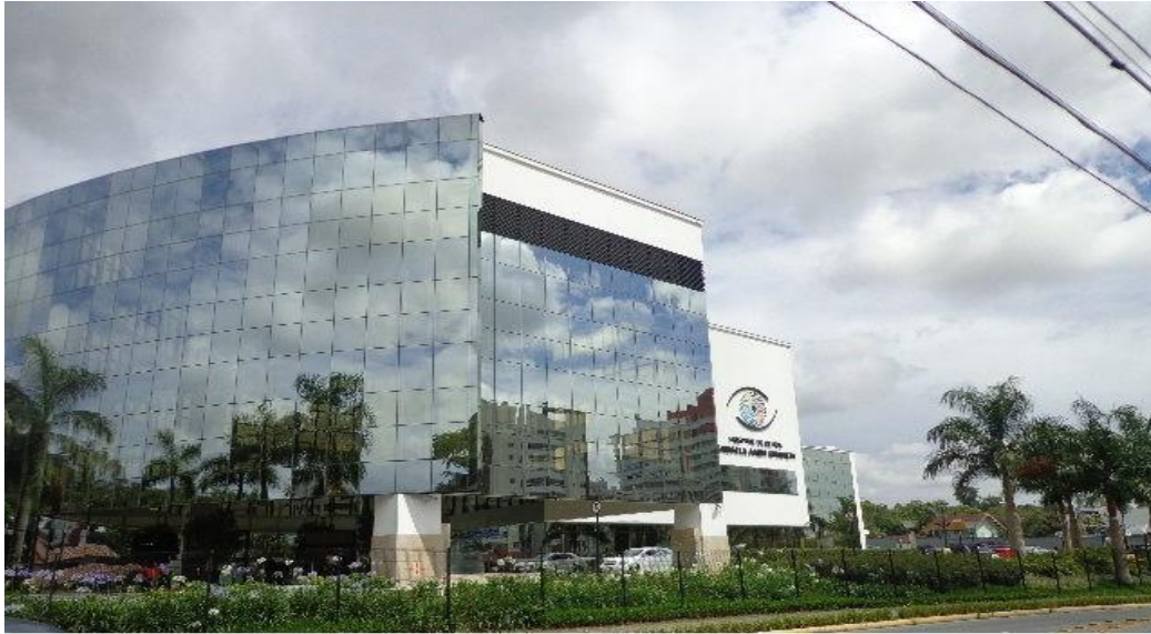
Rua: Camboriu, 910 Hospital de Olhos Terreno 7.232,47m 2 Edif. 10.200,72m 2 Inscr. Imob: 13-20-12-92-599
