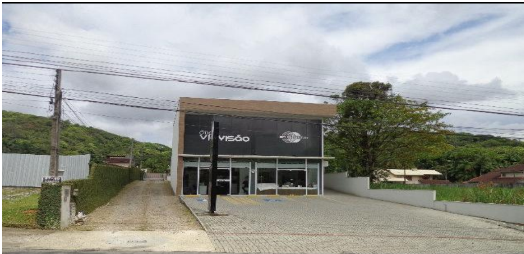
Rua: Camboriu, 85 Terreno 633,00 m 2 Edif. 354,19m 2 Inscr. Imob: 13-20-12-92-418
