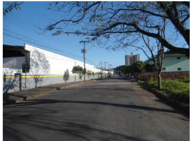
Figura 22: Já na orientação sul da mesma via, tem-se, as instalações da CELESC e uso residencial.
