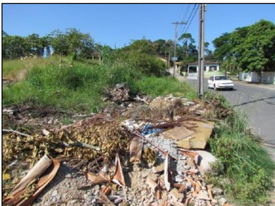
**Figura 122** - Disposição inadequada de resíduos da construção civil
