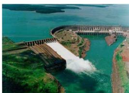
Usina Hidrelétrica de Itaipu
