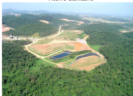
Aterro sanitário de Joinville - 2008
