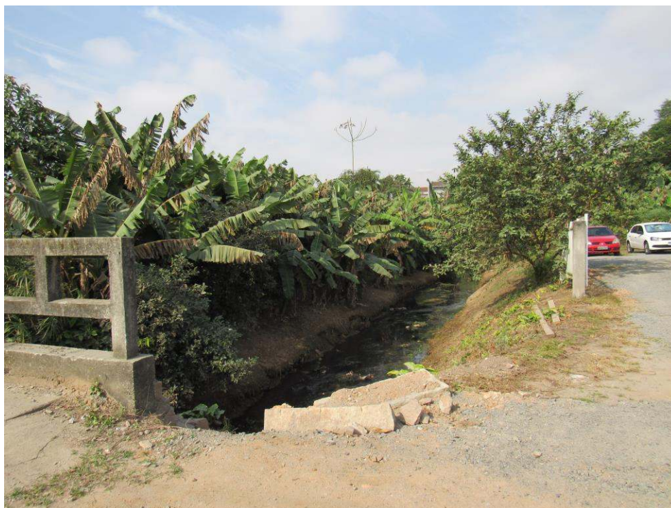
Figura 31: Final do trecho 19, aberto com vegetação isolada. Fonte: Autores.
