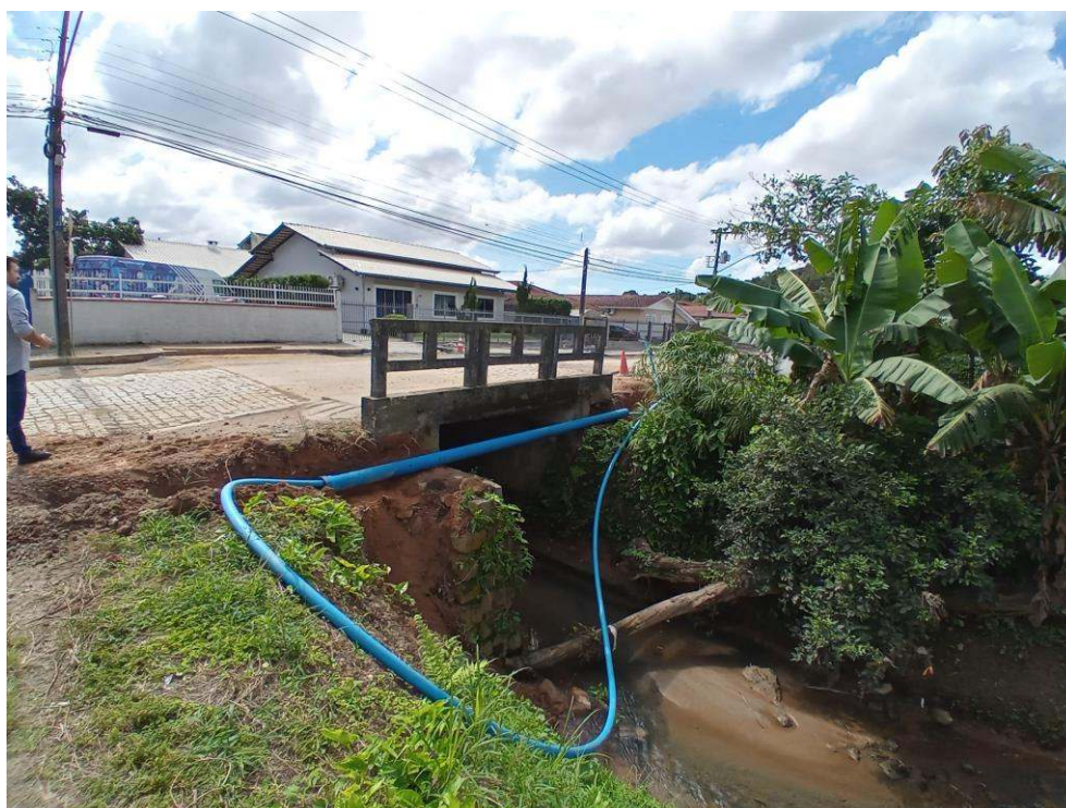
Figura 33: Final do trecho 19, vista para trecho 20, tubulado. Fonte: Autores.
