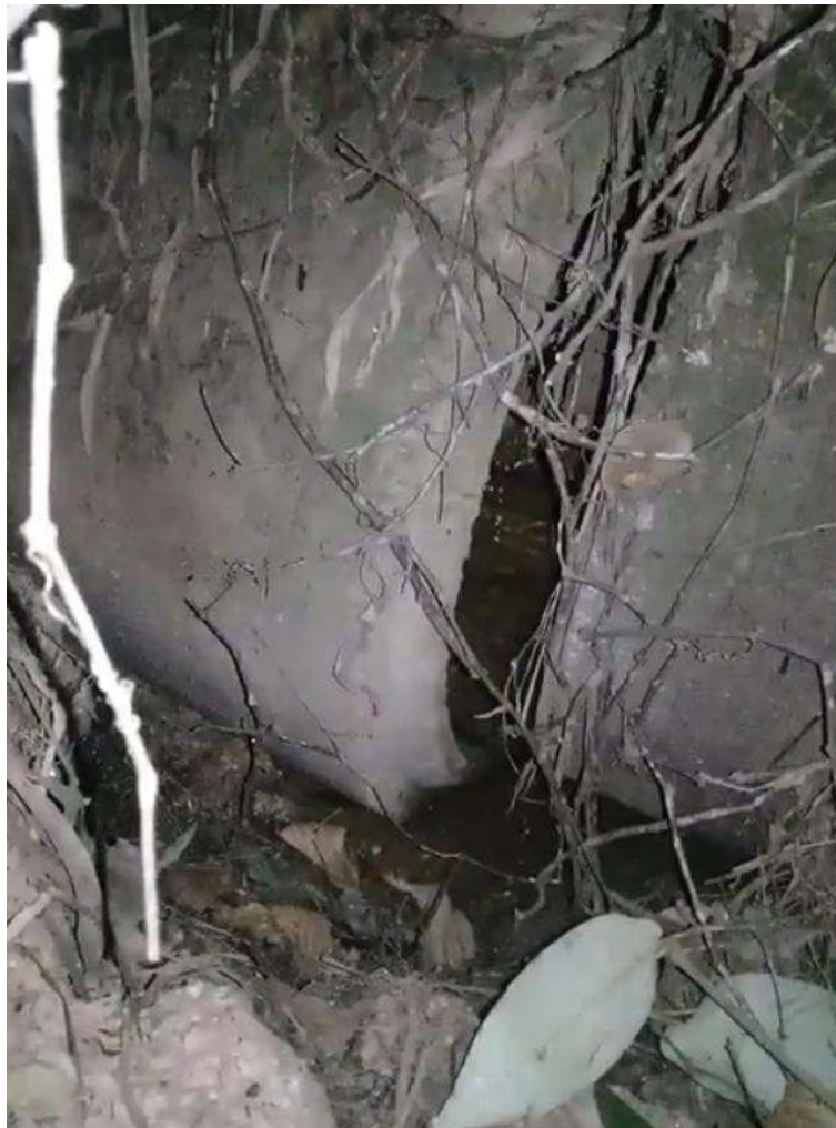
Figura 24: Detalhe para trecho tubulado 7. Fonte: Autores.
