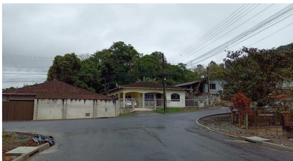
Figura 17: Boca de lobo na rua Caelum, esquina com rua Andromeda
