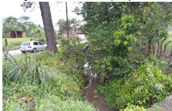
Figura 40: Trecho 56, vista para jusante.
