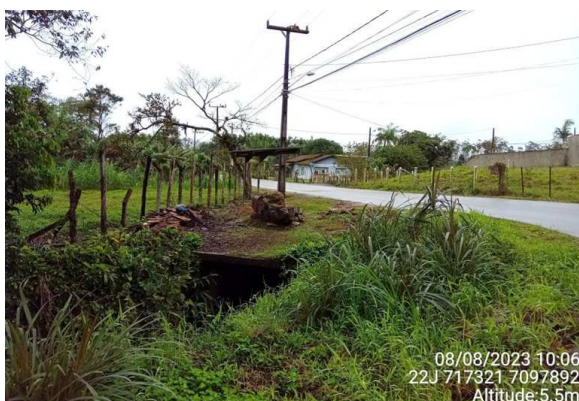
Figura 41: Trecho 59, vista para montante, margem direita.
