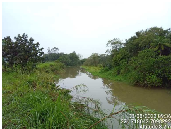
Figura 44: Trecho 76, vista para jusante, a partir da Estrada Timbé.
