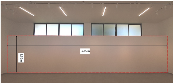
Foto 3 - Parede interna GMAVK
