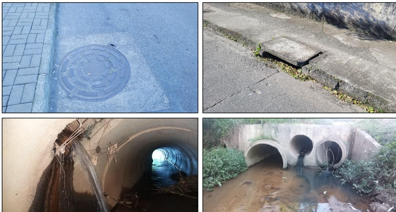
Figura 13 – Serviço de drenagem pluvial.
