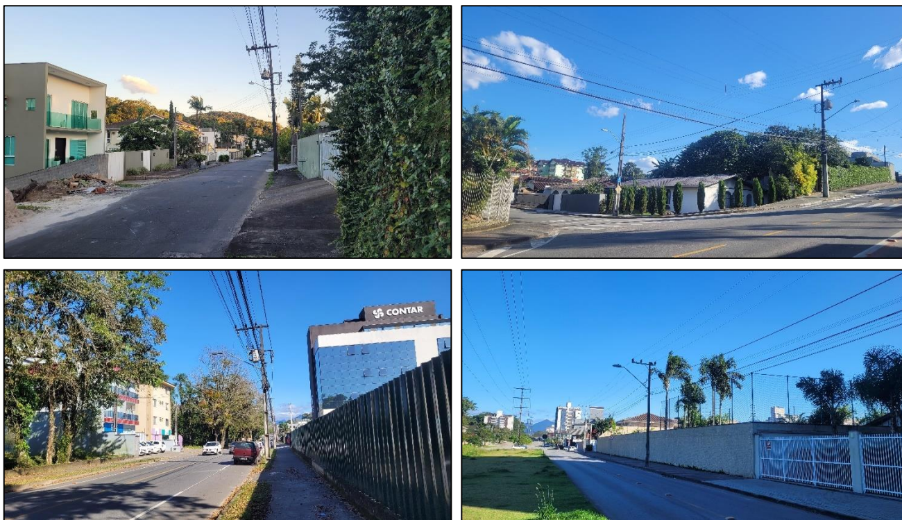
Figura 11 – Serviço de distribuição de energia elétrica e iluminação pública.
