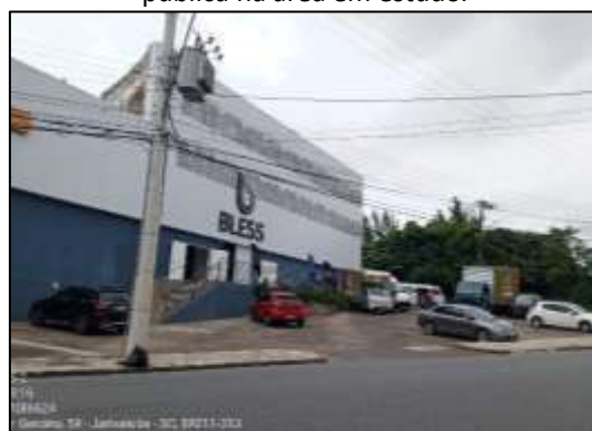
Figura 12: Rede de energia elétrica e iluminação pública na área em estudo.
