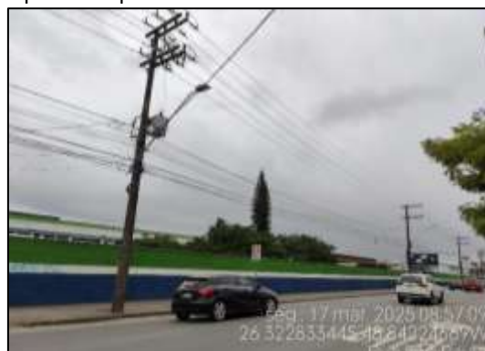
Figura 10: Rede de energia elétrica, iluminação pública e ponto de ônibus na área em estudo.
