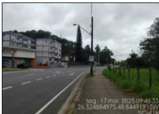
Figura 9: Rede de energia elétrica e de telefonia na área em estudo
