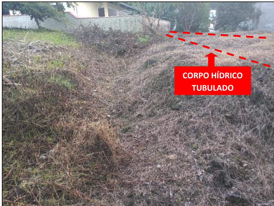
Figura 1: Parte do trecho 2B com corpo hídrico tubulado, onde passa por terreno que sofreu atividade de terraplanagem. Fonte: vistoria realizada no dia 12/05/2022 pela equipe técnica da Bioeco.
