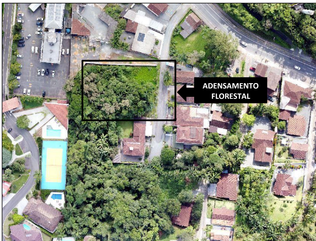
Figura 32: Caracterização do maciço florestal incidente sob a Área 07 , o qual configura-se por apresentar uma paisagem heterogênea, conectada a áreas florestais adjacentes. Fonte: imagem de drone - DJI Mini SE (2022).
