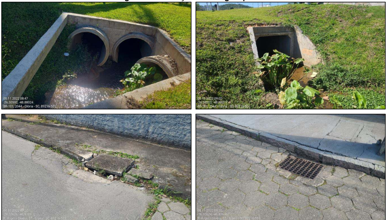
Figura 20 – Serviço de drenagem pluvial.
