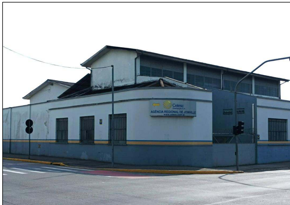
Figura 57: Subestação da CELESC, localizada na Rua Marques de Olinda, próximo ao trecho 4C. Fonte: vistoria realizada no dia 26/05/2022 pela equipe técnica da Bioeco.
