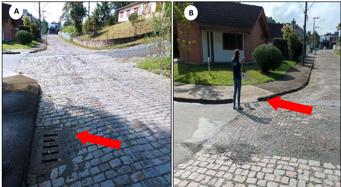
Figura 46: Bocas de lobo tipo grelha. Legenda: A – Registro boca de lobo localizada na Rua Netuno, próximo ao trecho 1. B – Boca de lobo localizada na esquina entre as ruas Netuno e José Bonifácio, próximo ao trecho 2B. Fonte: vistoria realizada no dia 10/05/2022 pela equipe técnica da Bioeco.
