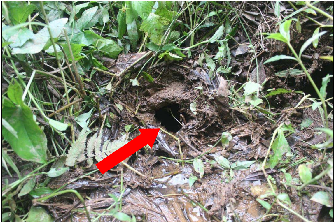
Figura 50: Ponto de integração de corpo d'água aberto à rede de drenagem pluvial, saída do trecho 7. Fonte: vistoria realizada no dia 10/05/2022 pela equipe técnica da Bioeco.
