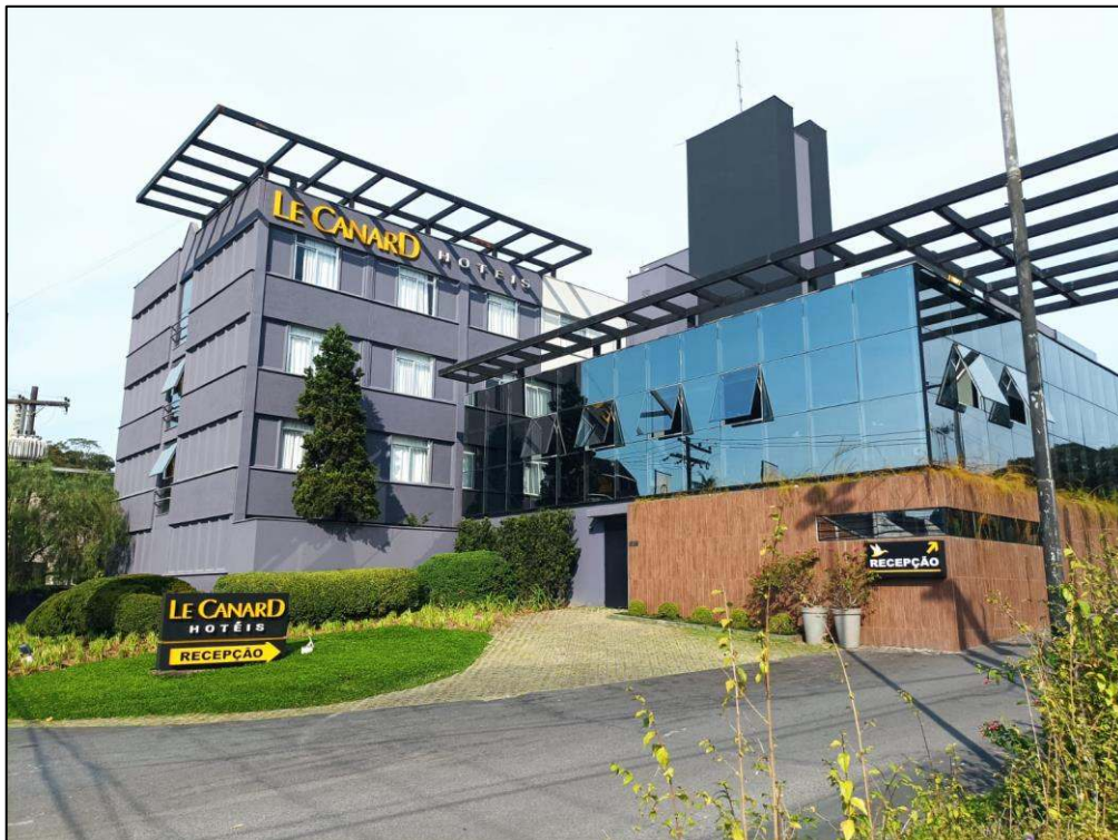
Figura 56: A – Hotel localizado na Rua XV de Novembro, próximo ao trecho 5A. Fonte: vistoria realizada no dia 26/05/2022 pela equipe técnica da Bioeco.
