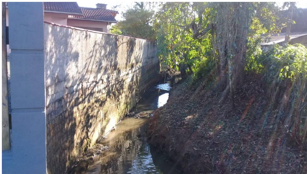
Figura 54: Trecho 46, com vista a partir do trecho 39. Fonte: Autores.
