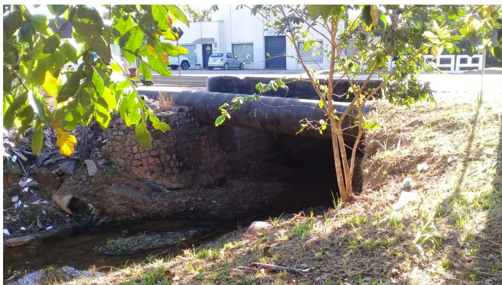
Figura 73: Trecho 78 (sob via), com vista do trecho 77.
