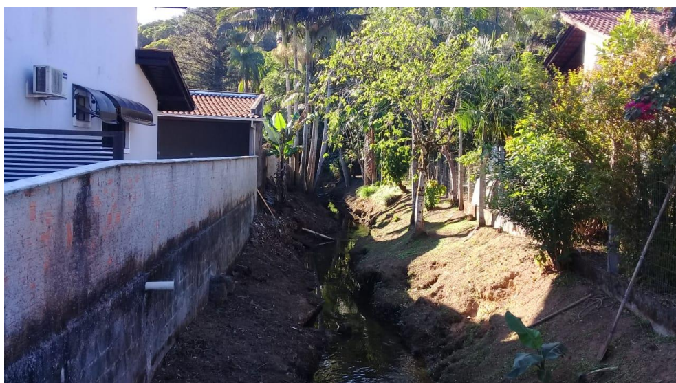
Figura 61: Trecho 52, com vista a partir do trecho 51.
