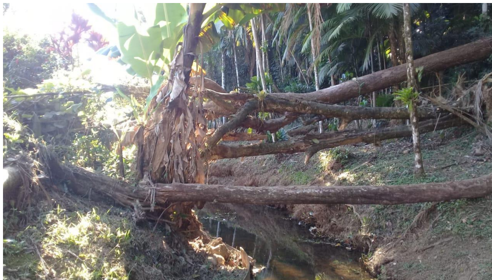
Figura 67: Trecho 71, início, vista para jusante. Fonte: Autores.
