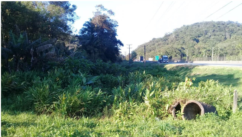
Figura 5: Vegetação no trecho 8, às margens da rodovia. Fonte: Autores.
