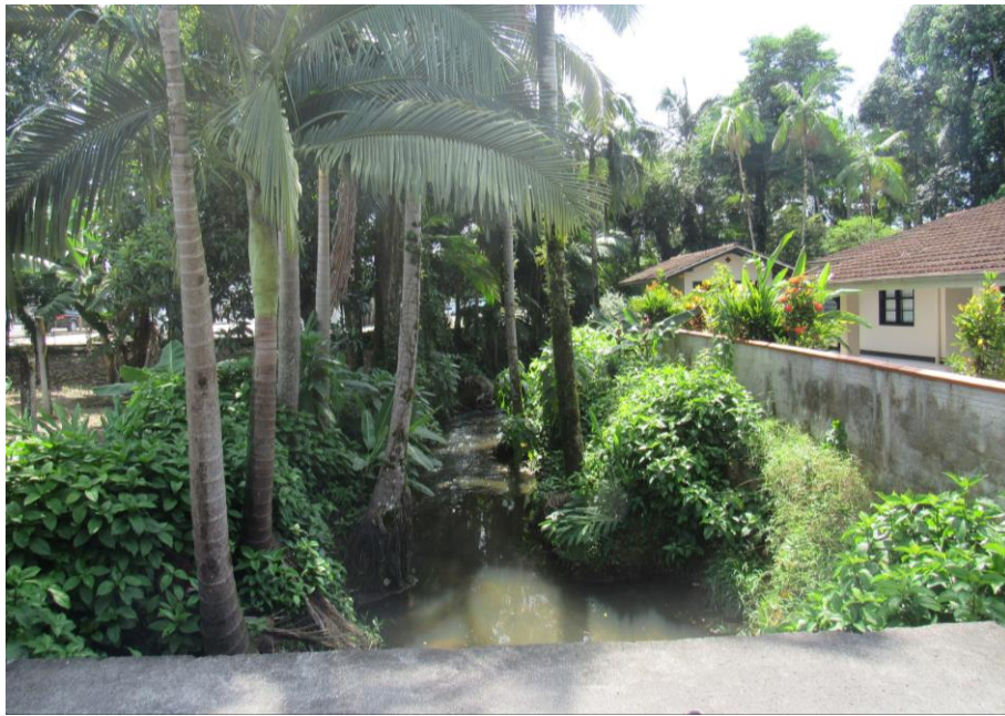
Figura 70: Trecho 76, vista para jusante. Fonte: Autores.
