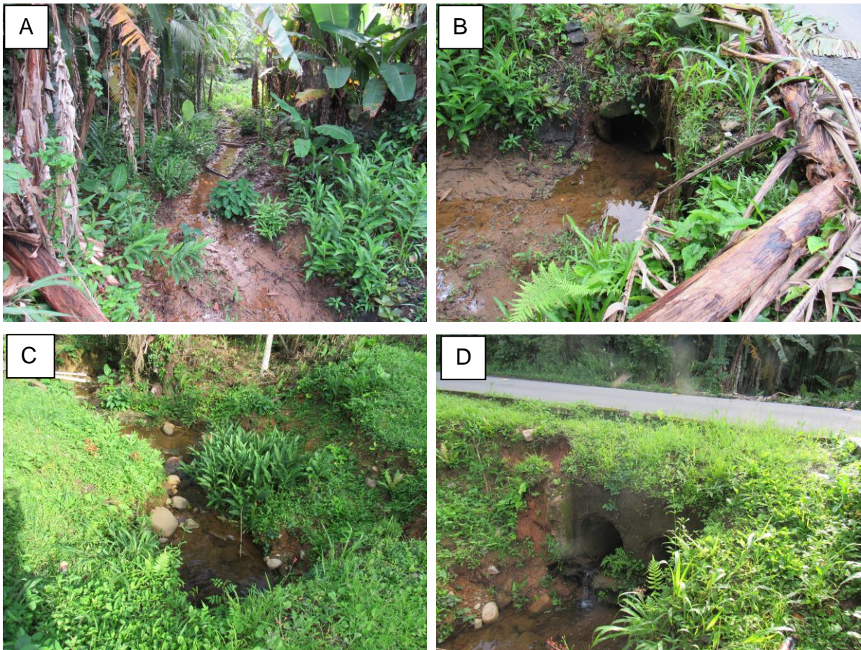
Figura 9: A) Vegetação onde o corpo d'água atravessa a rua Ver. Guilherme Zuege, trecho 20-21 (montante); B) Segmento 22, junto à via; C) Vista para trecho 22, em área vegetada antropizada; D) Curso d'água tubulado sob a via do trecho 21 para o trecho 22 (montante) Fonte: Autores.
