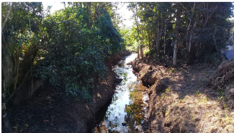
Figura 74: Trecho 79, com vista para jusante, a partir do trecho 78.
