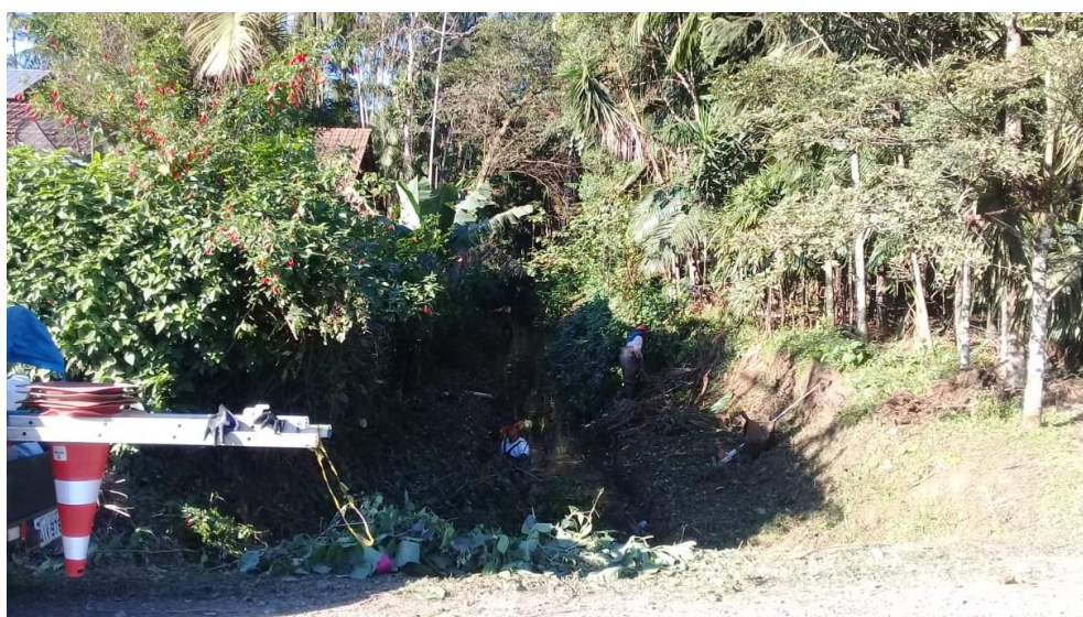
Figura 53: Trecho 38, com vista a partir do trecho 39. Observa-se serviço de limpeza das margens. Fonte: Autores.
