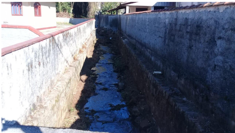
Figura 60: Trecho 50, com vista a partir do trecho 51.
