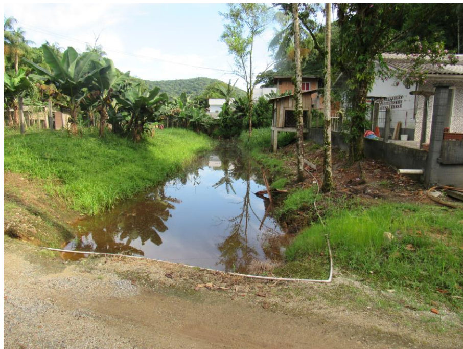
Figura 38: Trecho 3, vista para jusante. Fonte: Autores.
