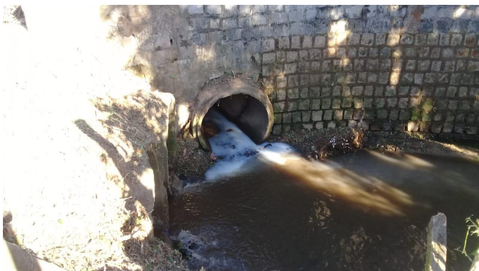
Figura 55: Detalhe do trecho 39 (tubulado) para trecho 46 (aberto). Observa-se espuma, provavelmente de águas cinzas residenciais. Fonte: Autores.
