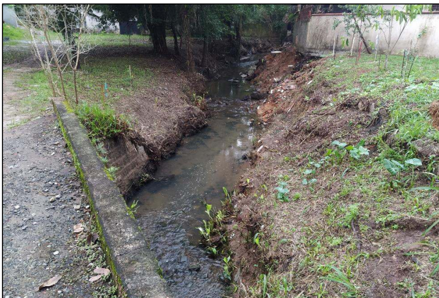
Figura 24: Trecho do curso hídrico que encontra-se como canal / galeria aberta, na rua Rio Grande do Sul.
