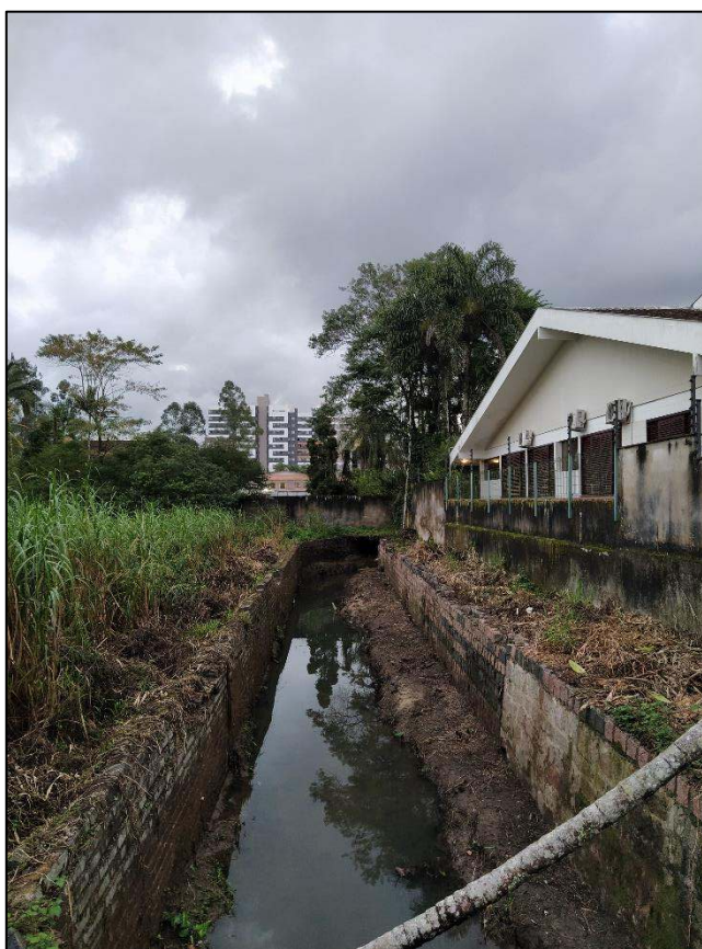
Figura 26: Trecho do curso hídrico que encontra-se como canal / galeria aberta, na rua Pernambuco. Vegetação formada por gramíneas.
