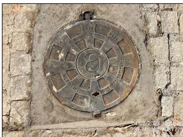
**Figura 3.5.1.8.3:** Caixa de inspeção de esgoto (Rua Padre Kolb). **Fonte:** OAP (2023).
