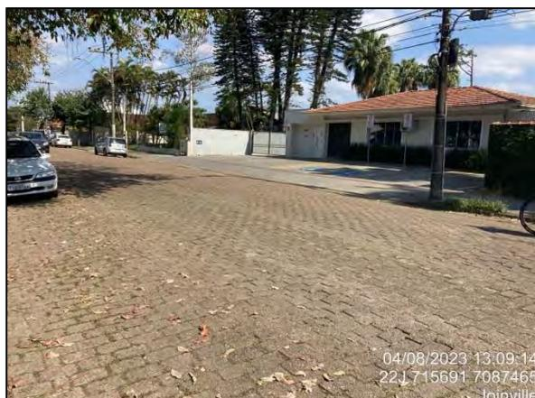
**Figura 3.5.1.1.3:** Detalhe de via com pavimentação de lajota/paver (Rua Urussanga). **Fonte:** OAP (2023).
