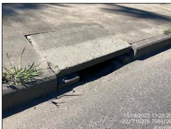
**Figura 3.5.1.5.3:** Dispositivo integrante do sistema de drenagem (Rua Aubé). **Fonte:** OAP (2023).
