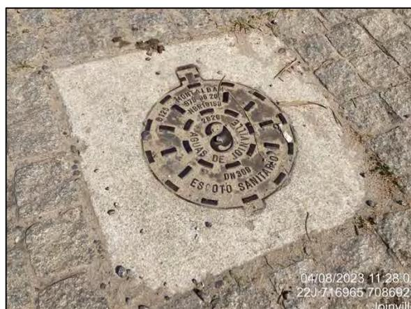
**Figura 3.5.1.8.4:** Caixas de inspeção de esgoto (Rua Guanabara). **Fonte:** OAP (2023).
