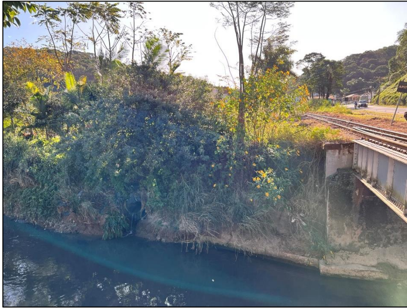
Figura 33 - Local de descarga do trecho 9 no Rio Itaum.
