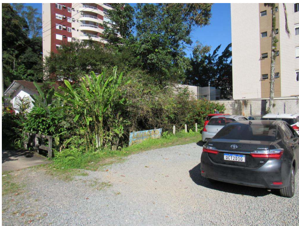
Fotografia 2: Trecho 18, galeria aberta, vegetação isolada, visada para montante, trecho 17, tubulado. Fonte: Autores.
