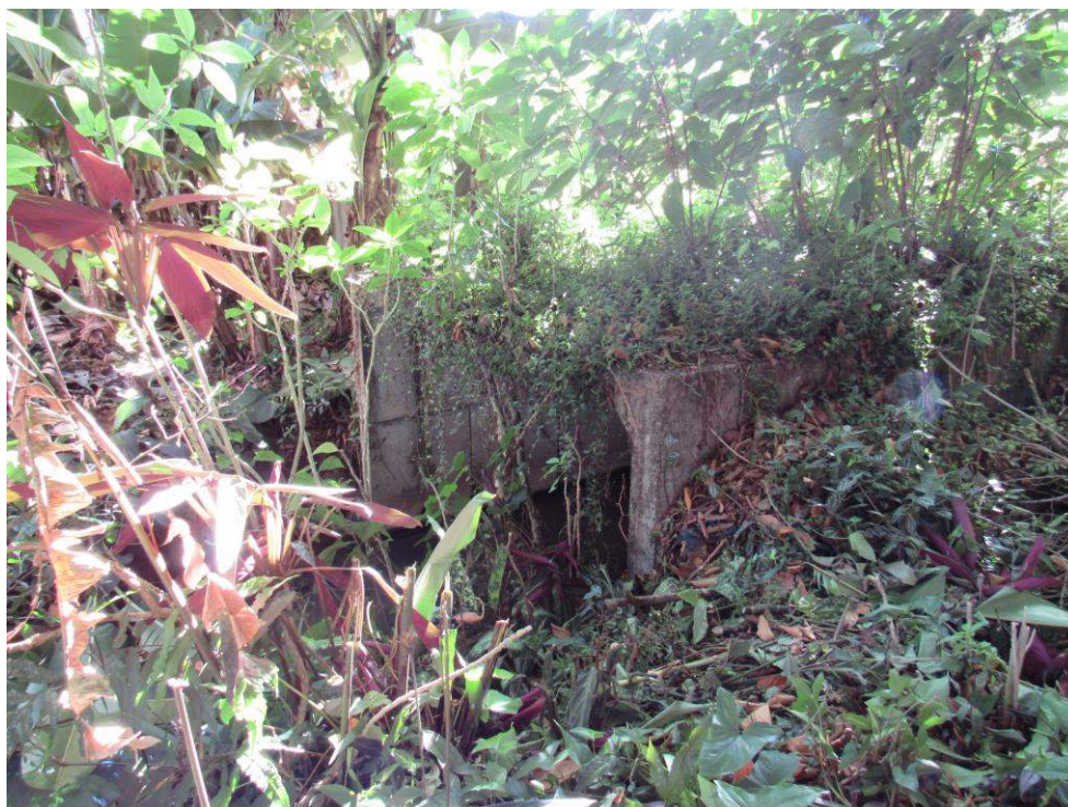
Fotografia 3: Trecho 20, visada para jusante, trecho retorna à tubulação a partir de trecho 21. Fonte: Autores.
