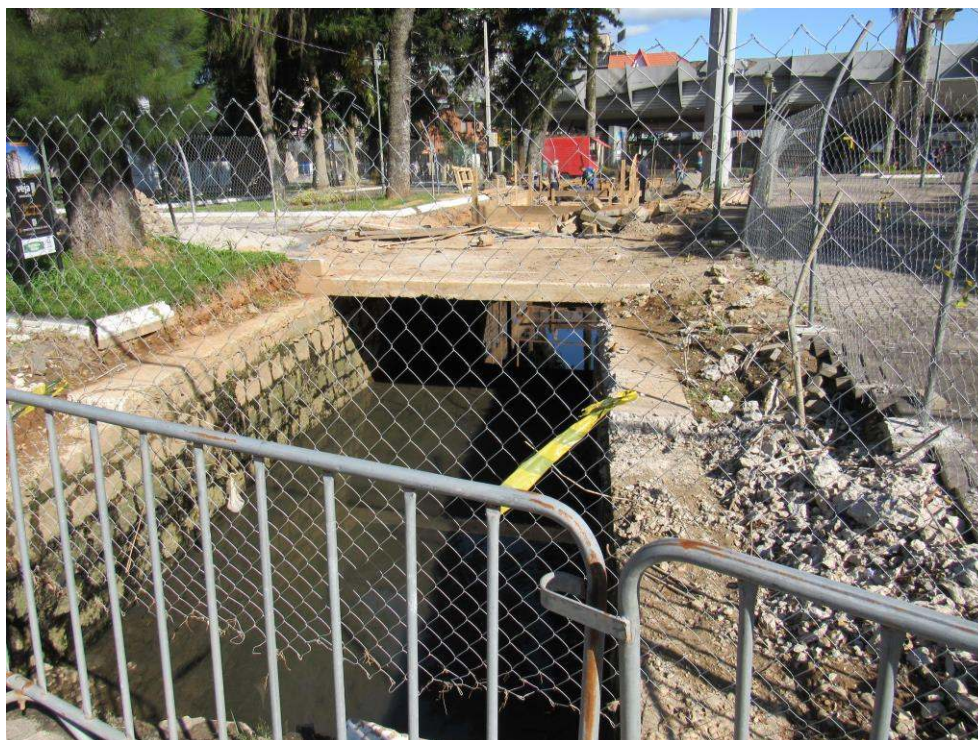
Fotografia 7: Trecho 38, em campanha de campo foi observado aberto para obras, visada para montante. Fonte: Autores.
