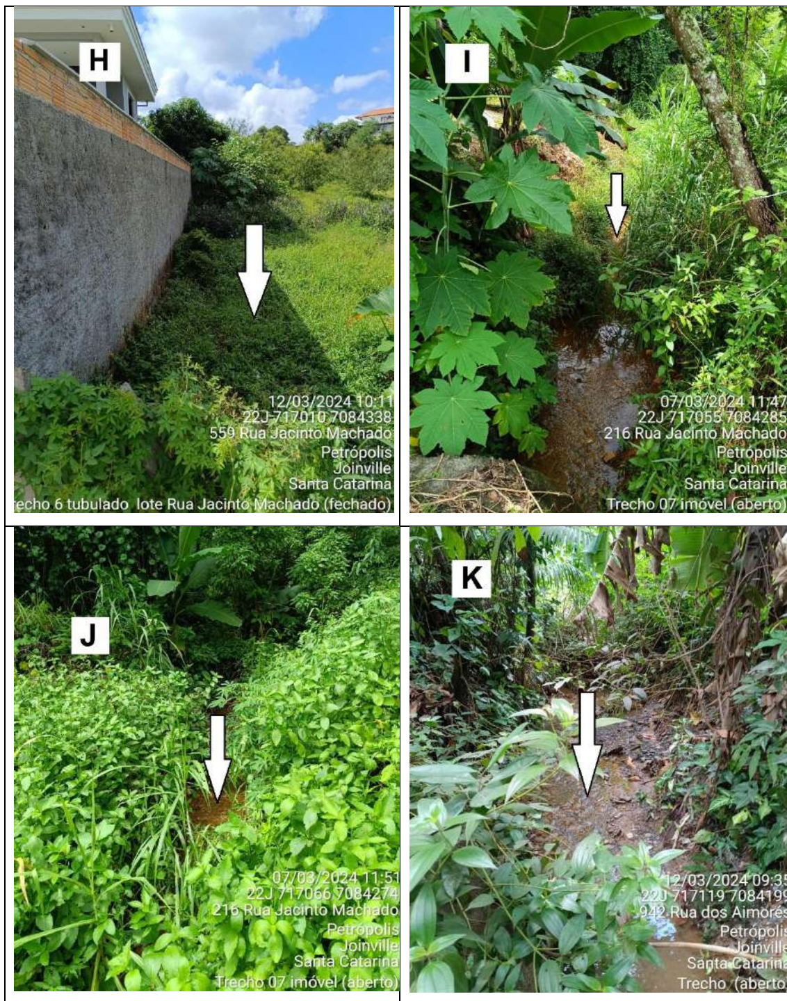
Figura 9: H (Trecho 6 tubulado lote = 717011.95 m E, 7084331.19 m S), I (Trecho 7 início galeria aberta = 717053.83 m E, 7084284.70 m S), J (Trecho 7 galeria aberta vegetação isolada = 717066.20 m E, 7084275.90 m S) e K (Trecho 7 galeria aberta vegetação densa = 717100.23 m E, 7084202.02 m S). Fonte: Autores
